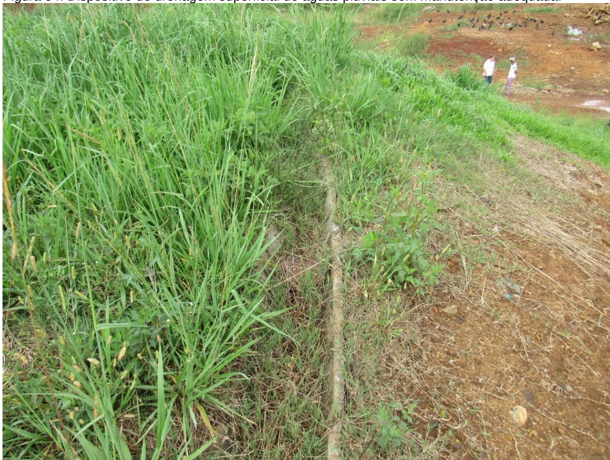
Figura 54: Dispositivo de drenagem superficial de águas pluviais sem manutenção adequada.
