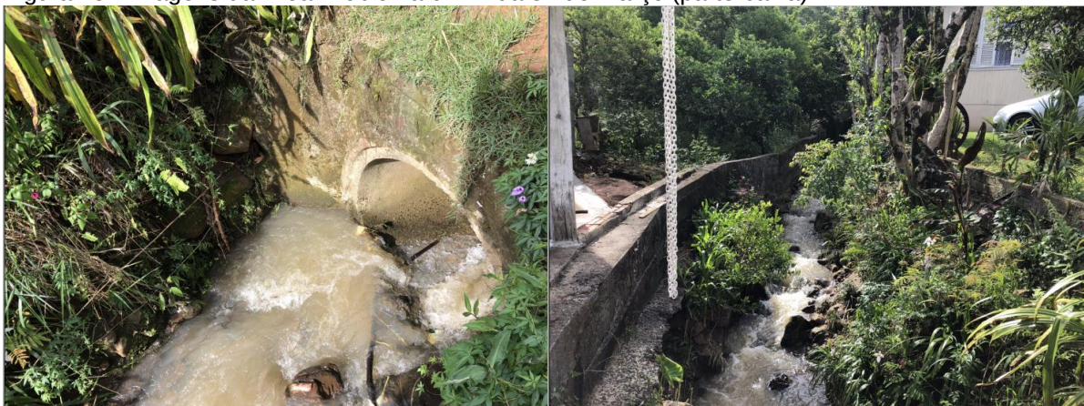
Figura 73 - Imagens da Área Problema 04 - Rua 31 de Março (parte baixa)
