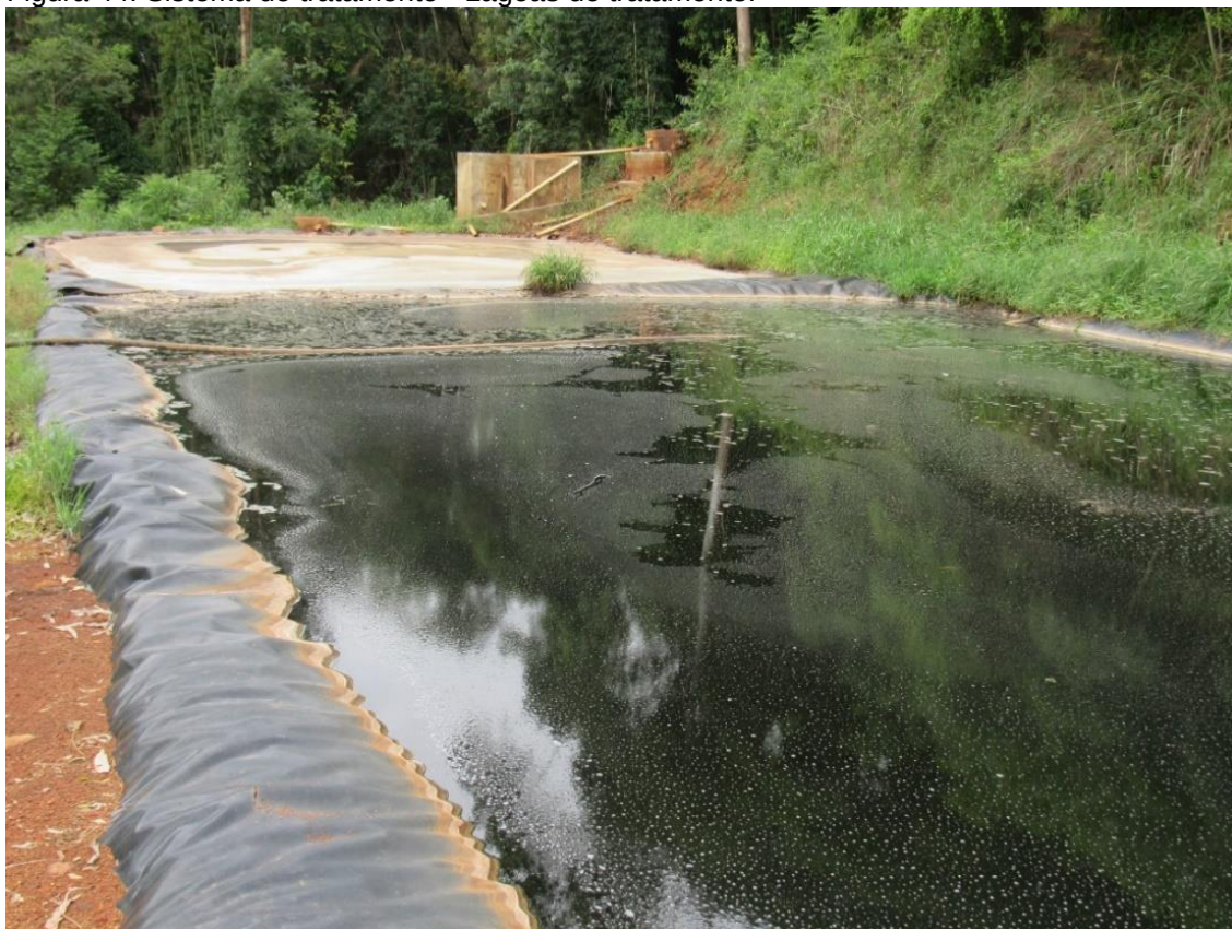
Figura 44: Sistema de tratamento - Lagoas de tratamento.
