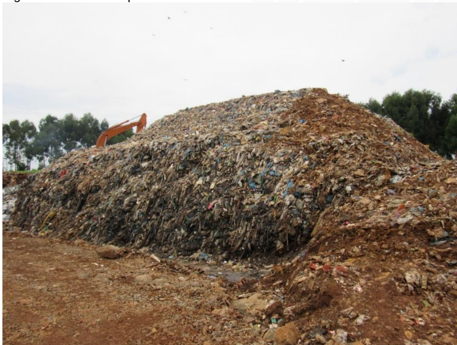
Figura 40: Taludes expostos sem cobertura.
