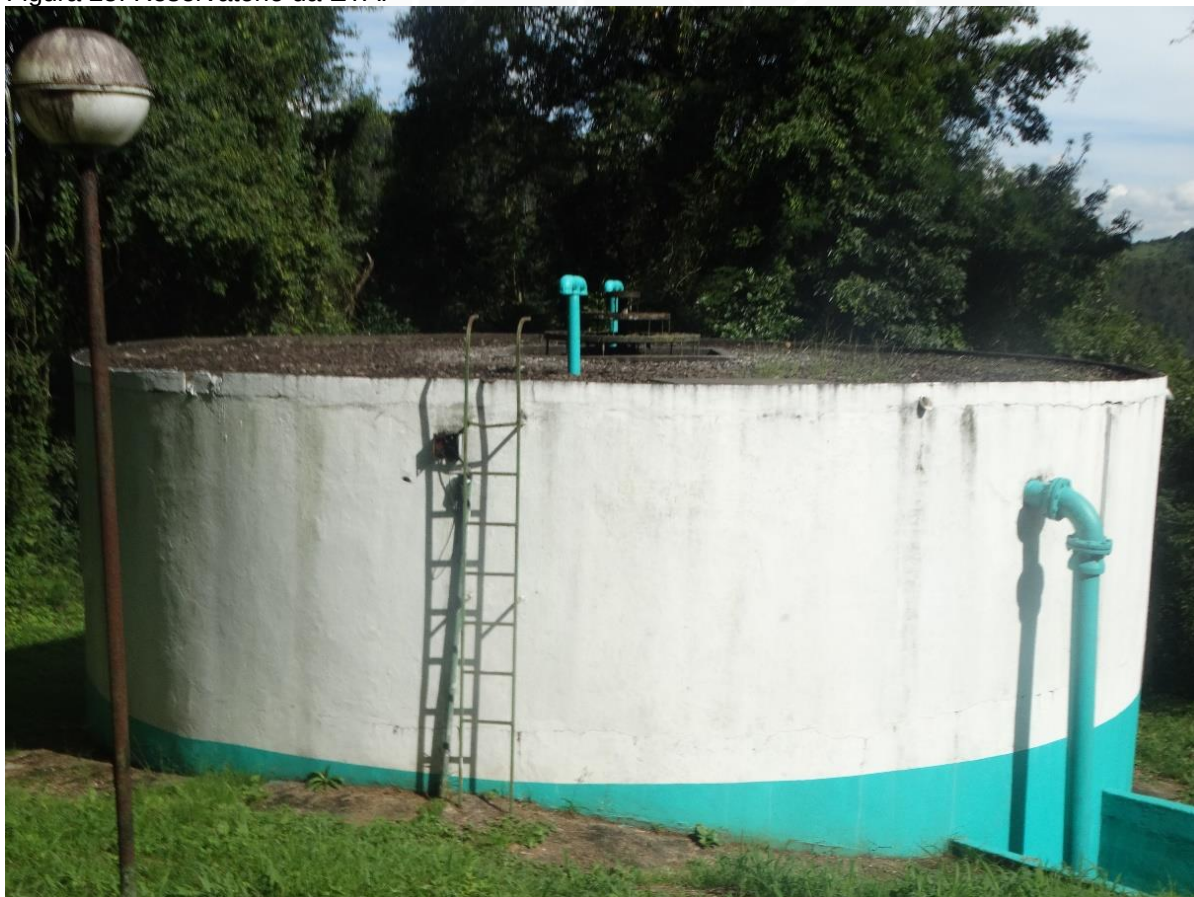
Figura 25: Reservatório da ETA.
