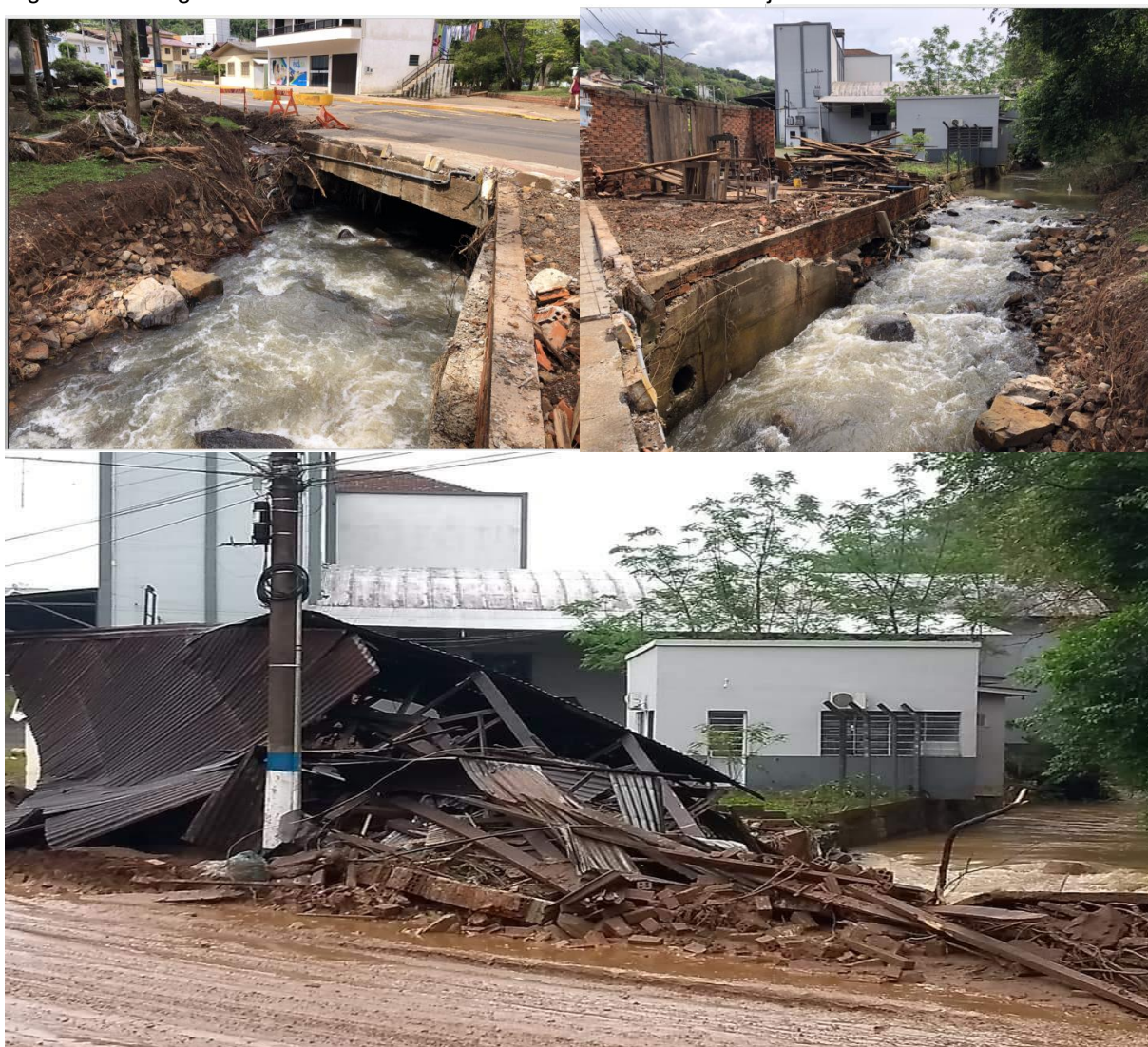
Figura 69 - Imagens da Área Problema 02 - Galeria Área Central Lajeado Nair
