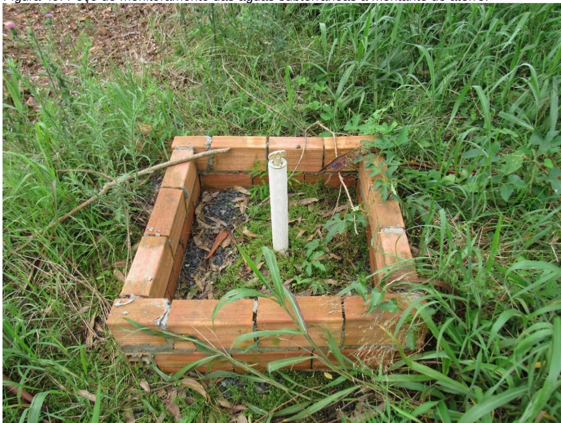
Figura 49: Poço de monitoramento das águas subterrâneas à montante do aterro.
