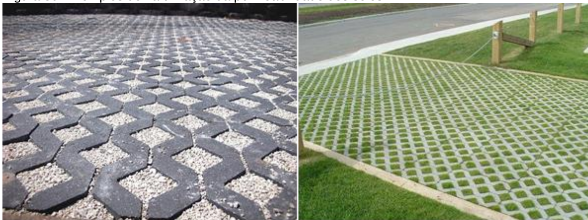
Figura 80: Exemplos de valorização da permeabilidade dos solos.
