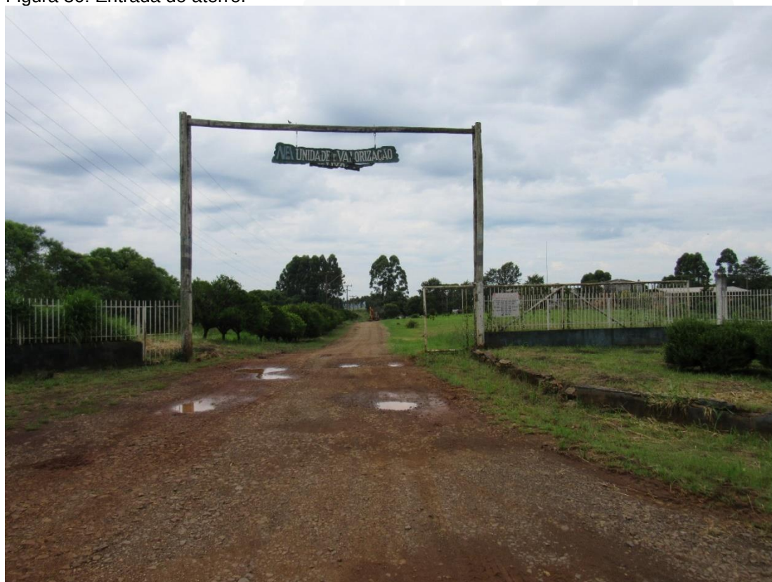
Figura 36: Entrada do aterro.
