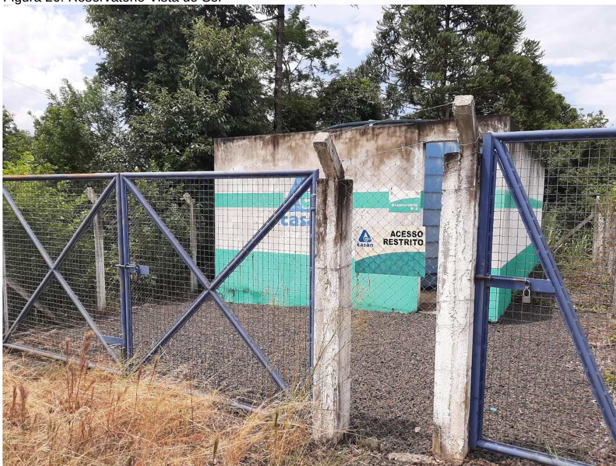
Figura 26: Reservatório Vista do Sol
