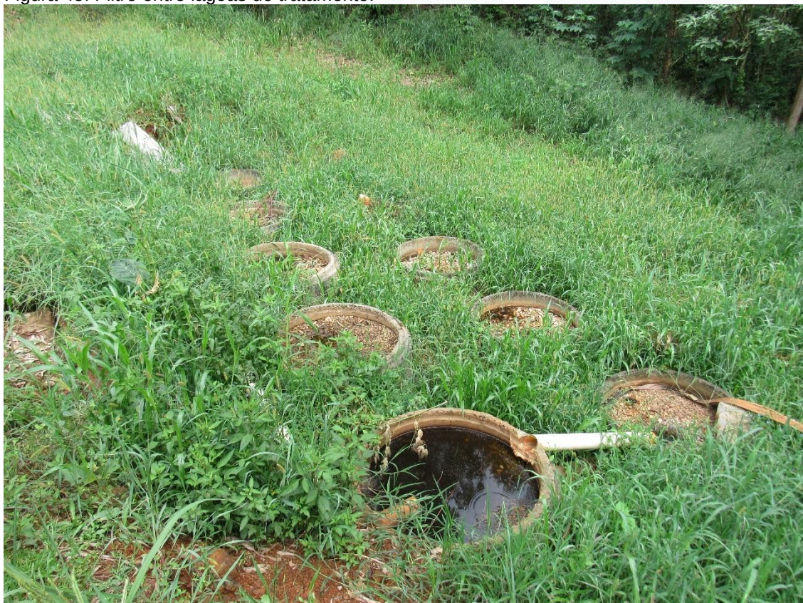
Figura 45: Filtro entre lagoas de tratamento.
