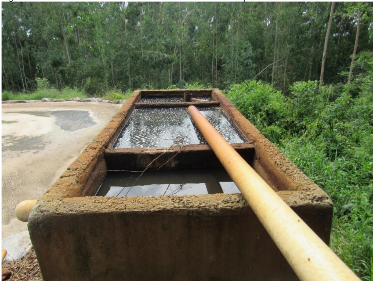
Figura 43: Entrada do chorume no tratamento – Caixa de decantação
