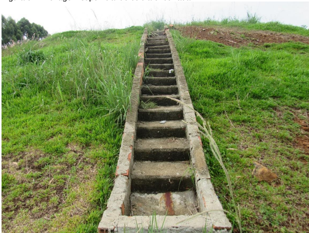
Figura 52: Drenagem superficial de célula encerrada.
