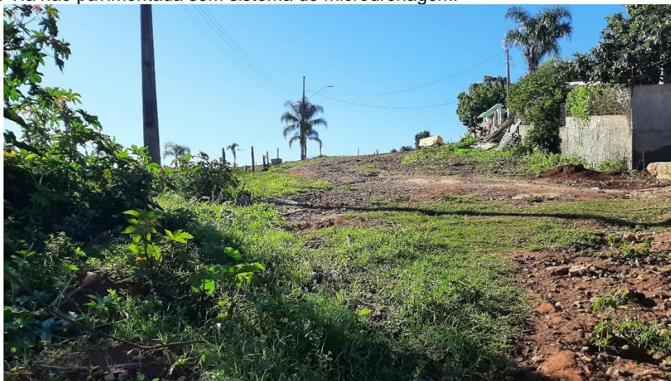
Figura 27: Via não pavimentada sem sistema de microdrenagem.
