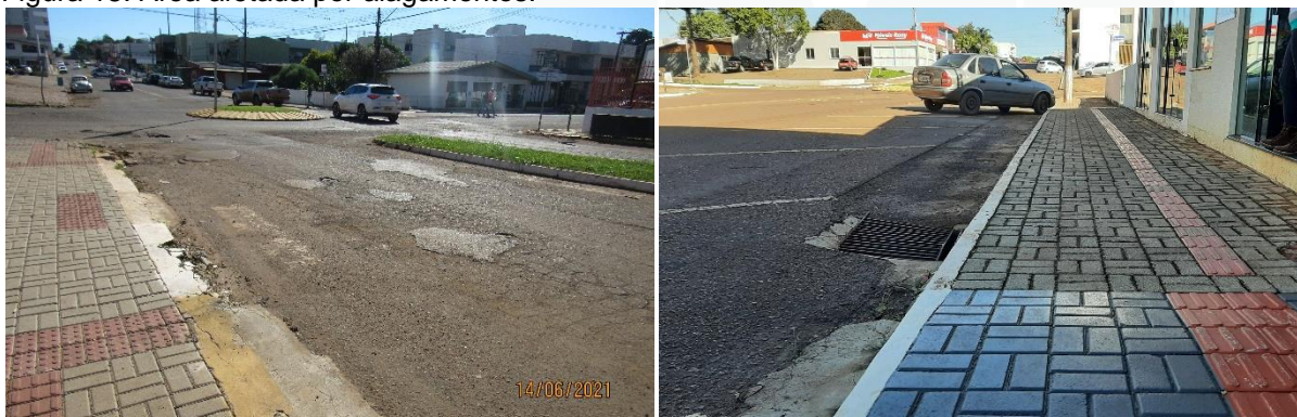
Figura 18: Área afetada por alagamentos.
