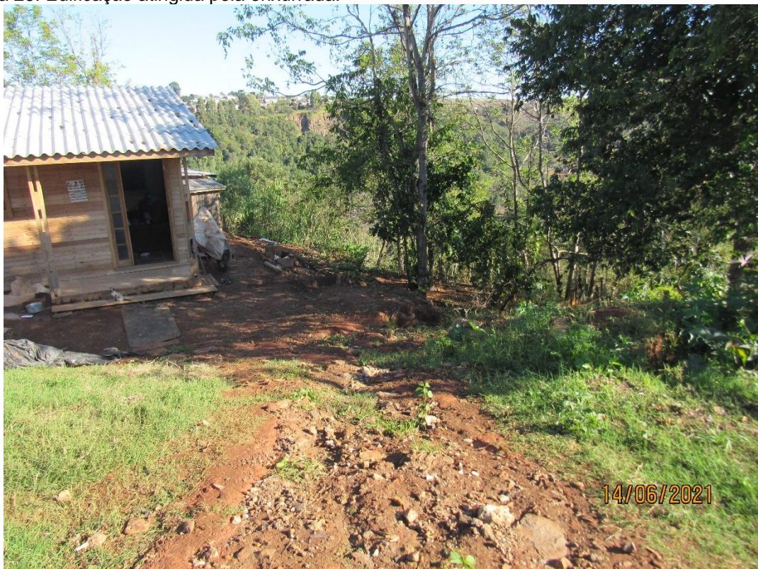
Figura 26: Edificação atingida pela enxurrada.
