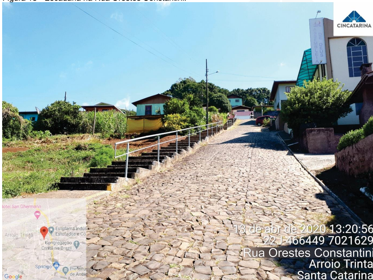
Figura 13 - Escadaria na Rua Orestes Constantini.
