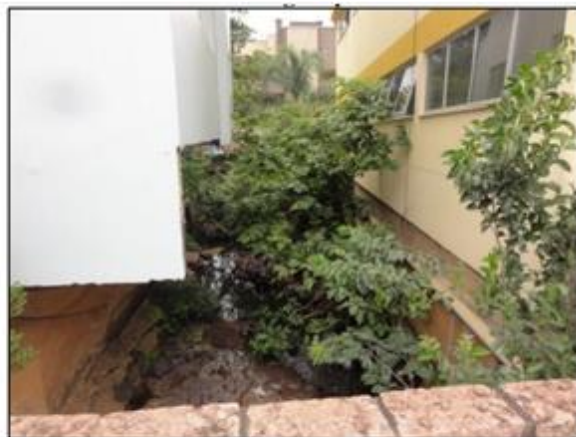
Figura 9. Moradias construídas acima e junto ao leito do Rio Trintinha na Rua Galdino Nezi.
