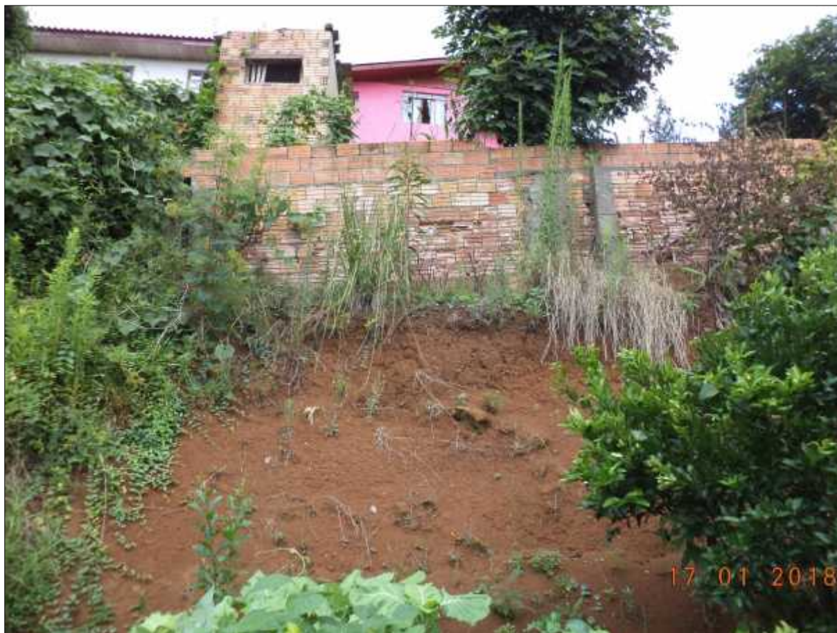
Figura 65 - Muro localizado no ponto RG22.
