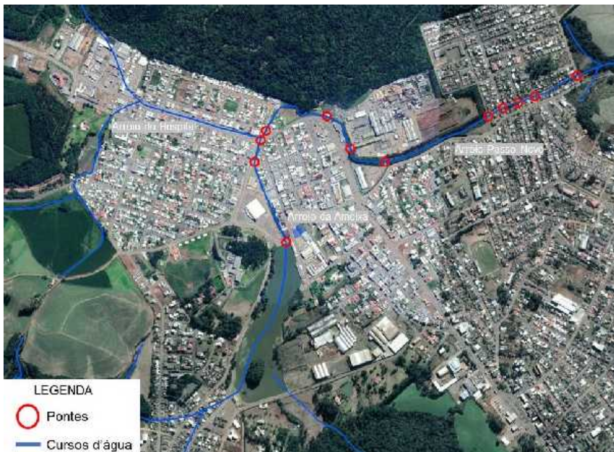
Figura 15 - Pontes sobre cursos d'água no perímetro urbano - Fraiburgo/SC
