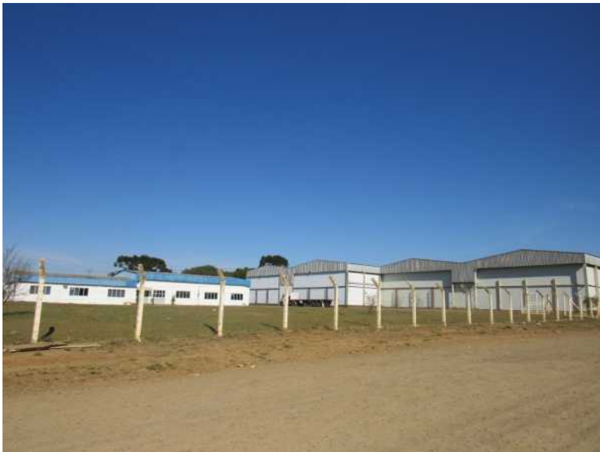
Figura 189 - Edificações industriais, Avenida Guenerino Agostini, Liberata.
