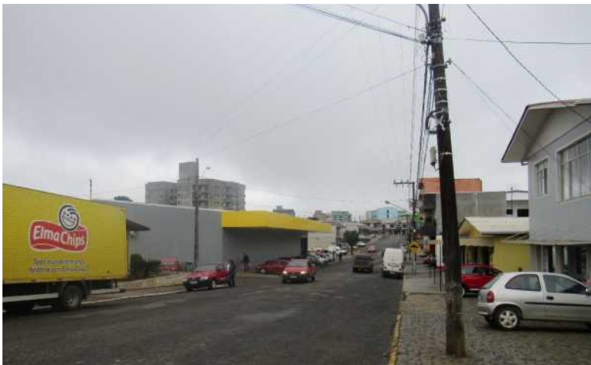
Figura 170 - Avenida Curitibanos, Centro.
