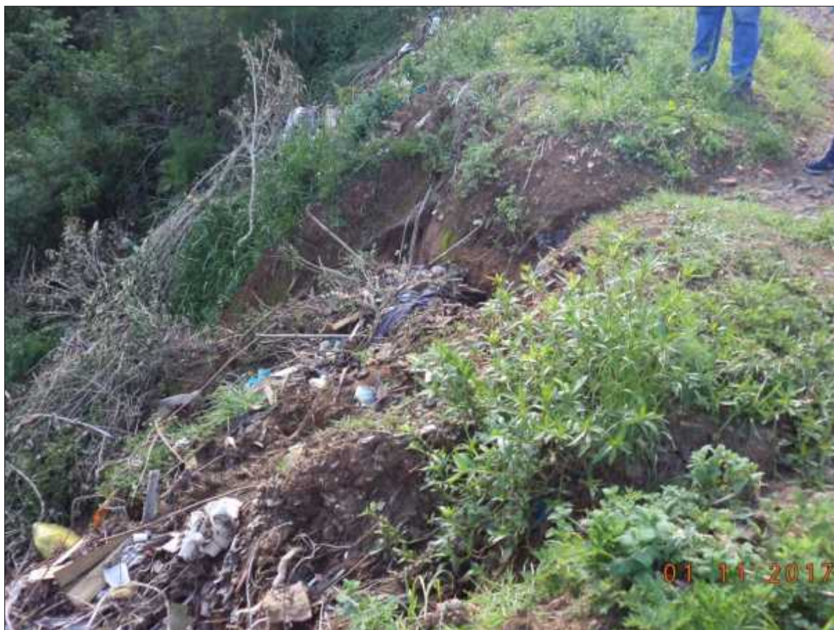
Figura 58 - Área de risco encontrada na rua Lodovico Salagna, ponto RG17. Vê-se os sulcos sendo formados na encosta e o acúmulo de lixo
