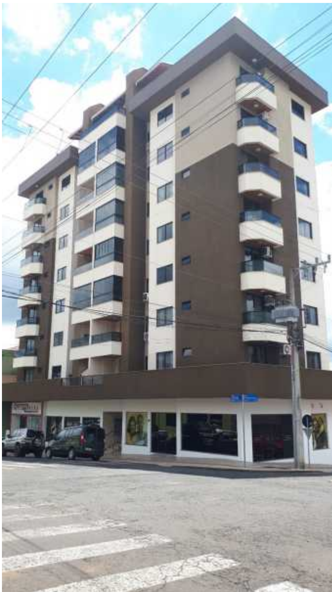
Figura 174 - Edifício na Rua Padre Biagio Simonetti, Centro.
