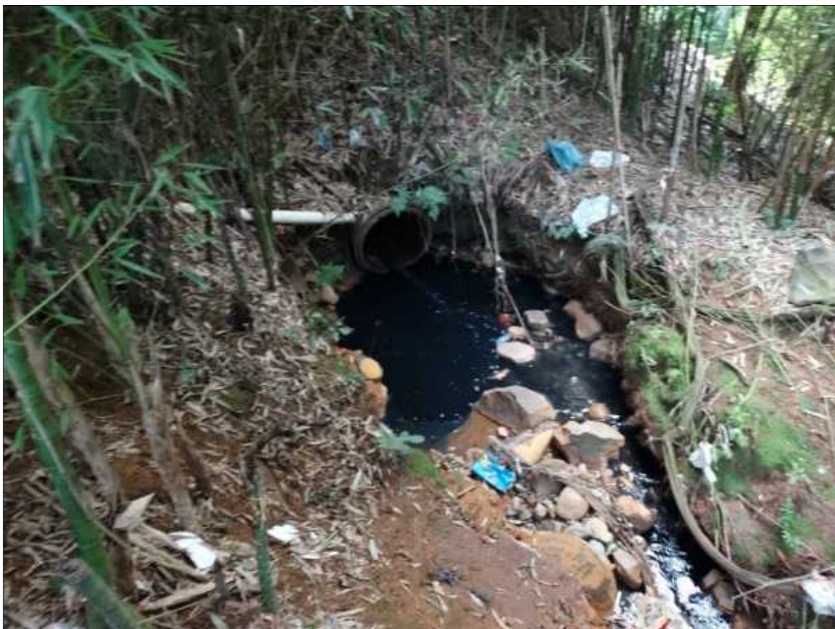
Figura 30 - Lançamento de esgoto pontual no dia 13/06/2017
