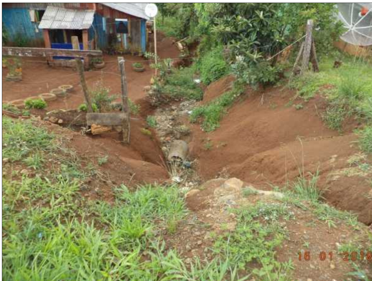
Figura 47 - Erosão que vem ocorrendo nesta porção do terreno, que se encontra desprotegido. Vê-se os sulcos formados pela chuva, no ponto RG09.
