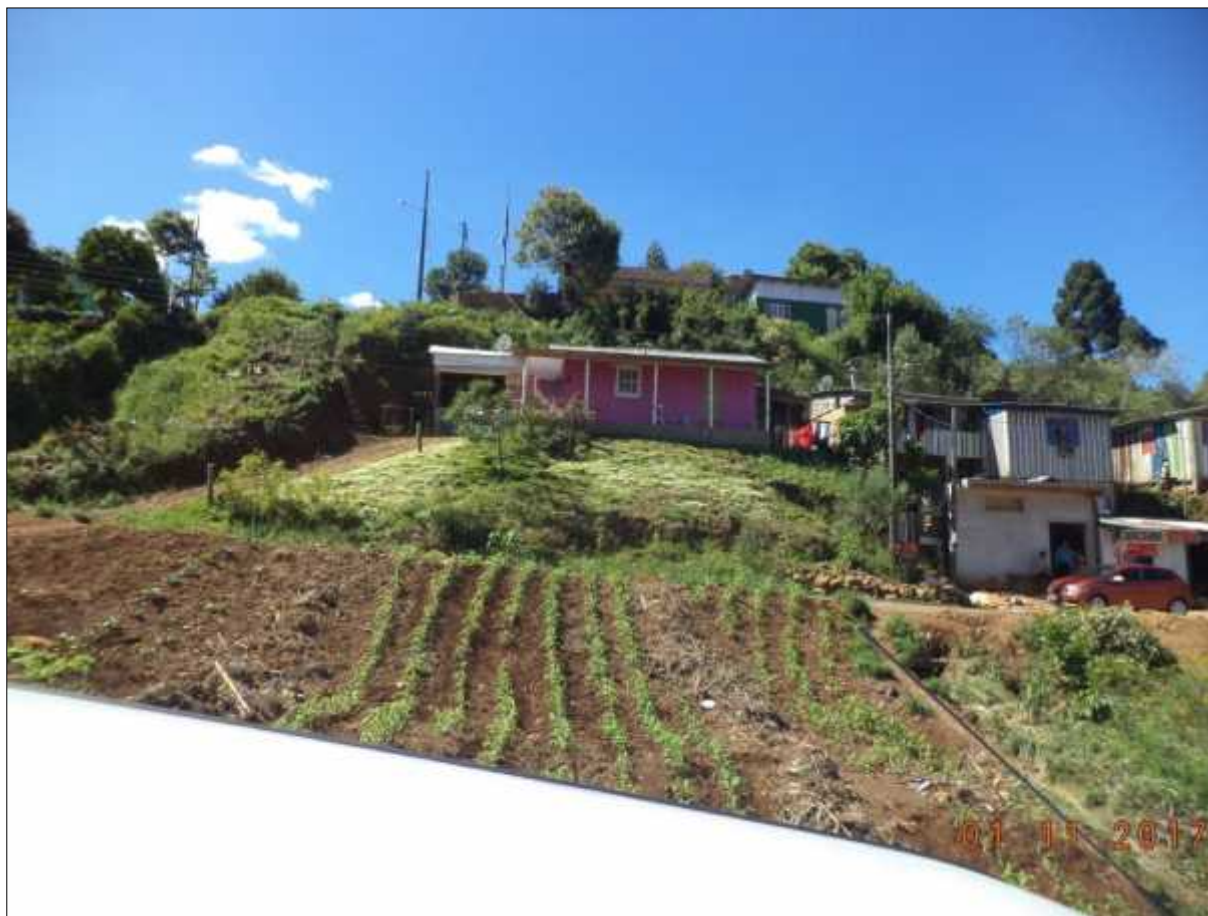
Figura 44 - Área de risco localizada no bairro São Miguel, no ponto RG06.
