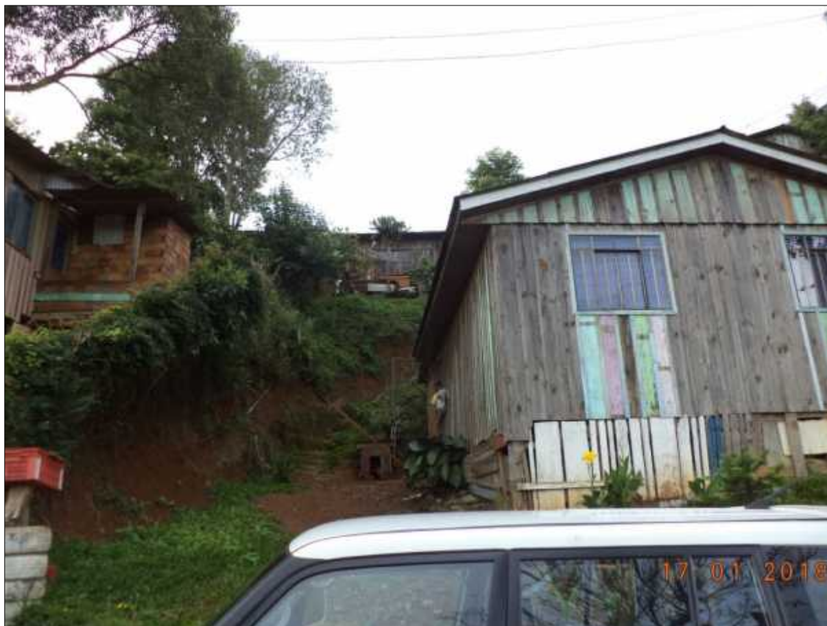
Figura 52 - Residência em área de risco, ponto RG13, localizada no bairro N. Sra. Aparecida.
