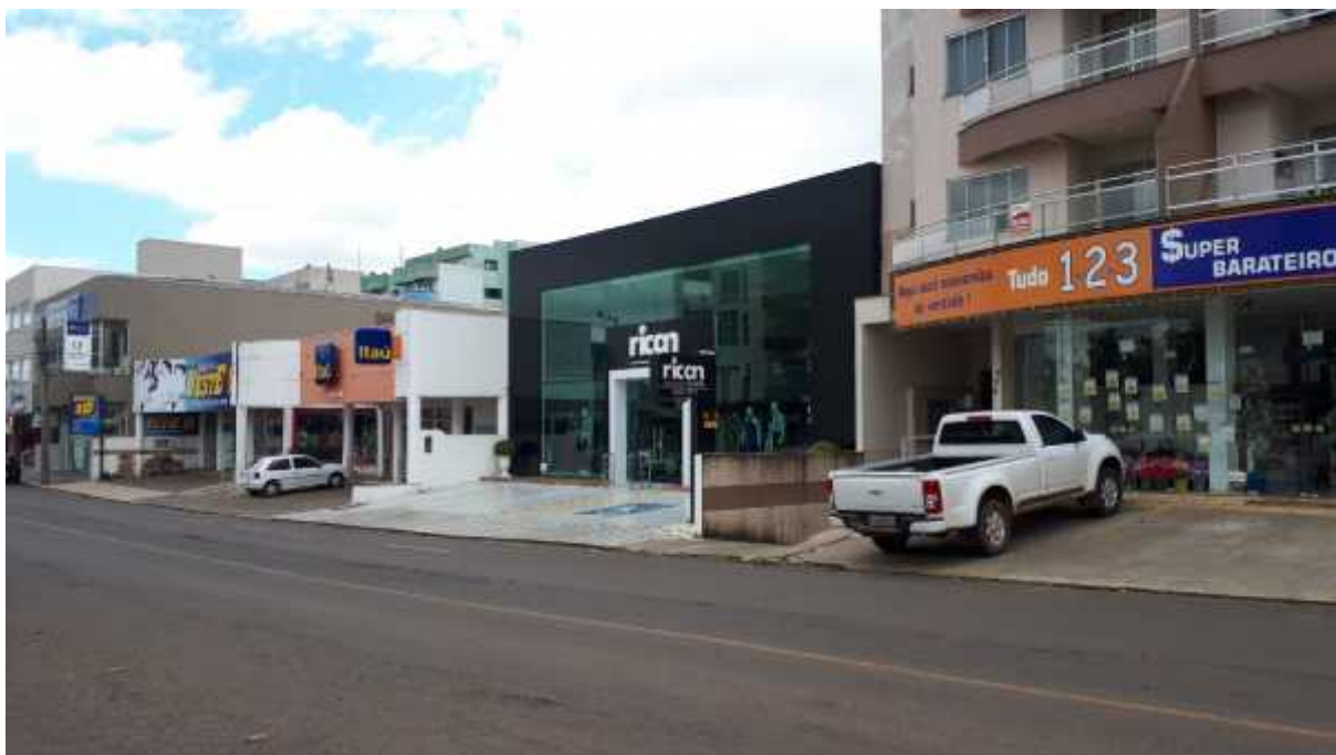
Figura 175 - Estacionamento no recuo frontal das edificações, na Rua Nereu Ramos, Centro.
