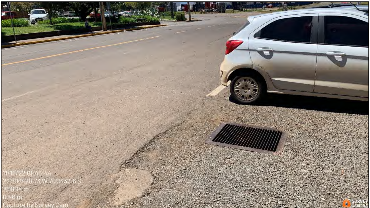
Figura 260: Boca de lobo responsável pela coleta e afastamento da água precipitada na AP-07 – 11/2022.
