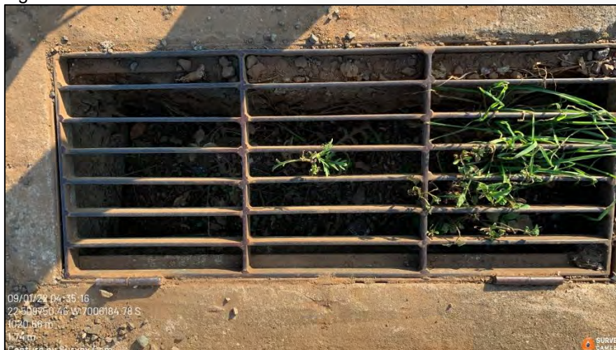
Figura 282: Boca de lobo da AP-12 – 09/2022.
