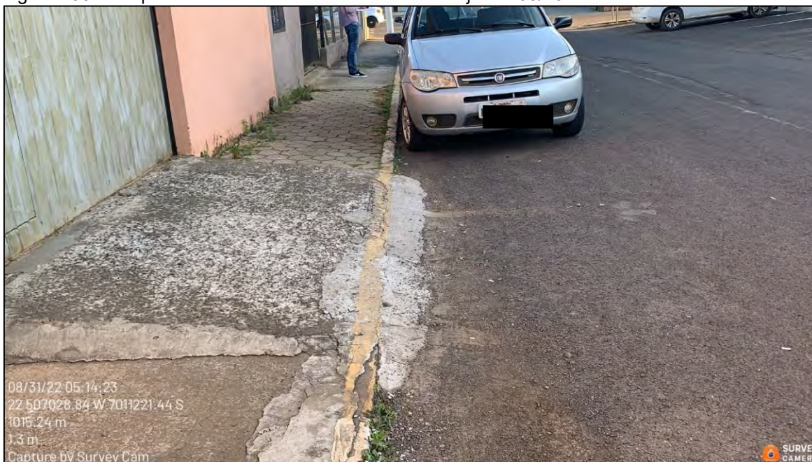
Figura 258: Rampas de acesso aos lotes na área de sarjeta – 08/2022.
