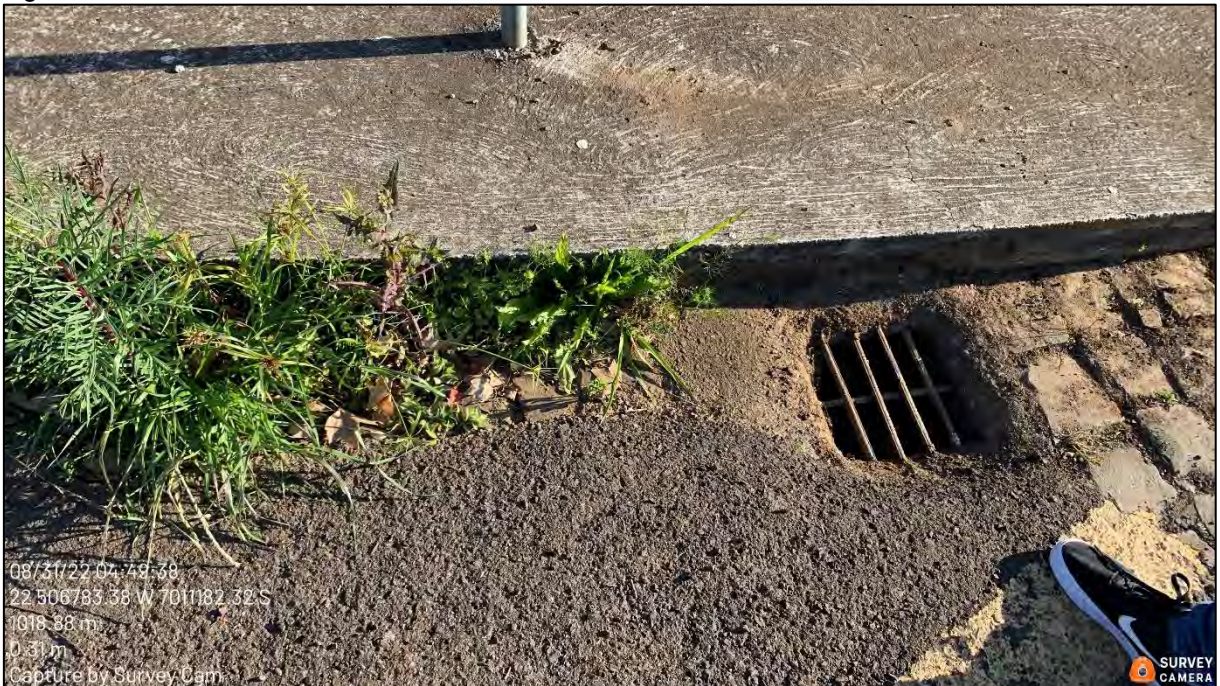
Figura 307: Boca de lobo da AP-18 – 08/2022.
