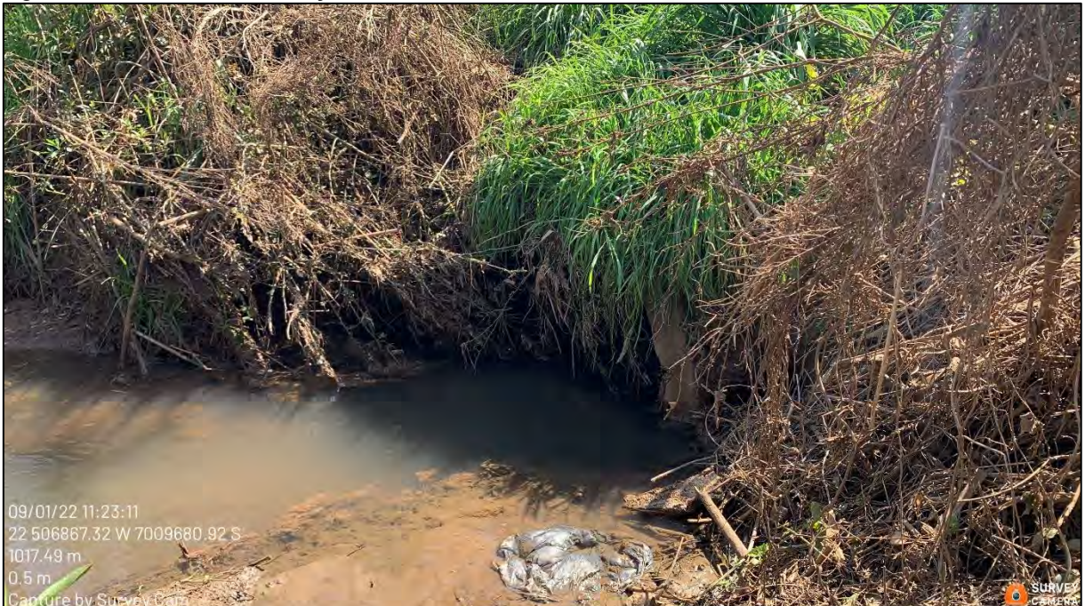
Figura 310: Entrada da tubulação – 09/2022.
