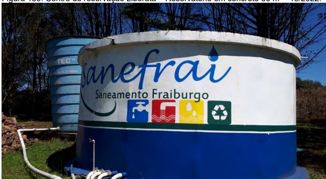
Figura 139: Centro de reservação Liberata – Reservatório em concreto 50 m 3 - 10/2022.
