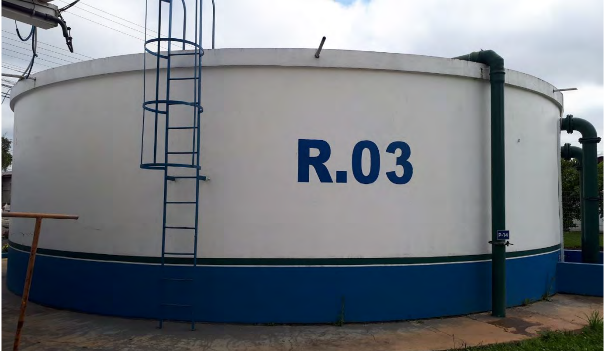
Figura 91: Centro de reservação ETA - Reservatório R.03 -10/2022.
