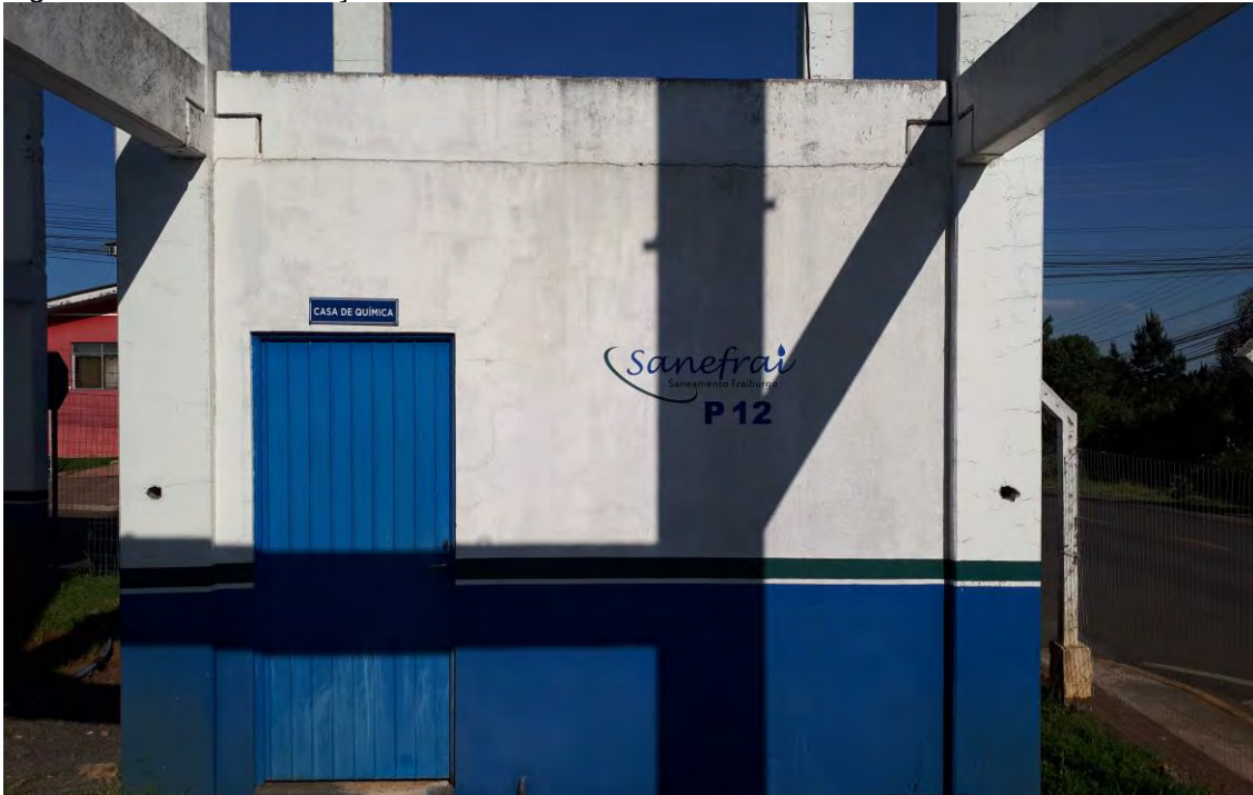
Figura 78: UTS P12 – Poço Montana -10/2022.
