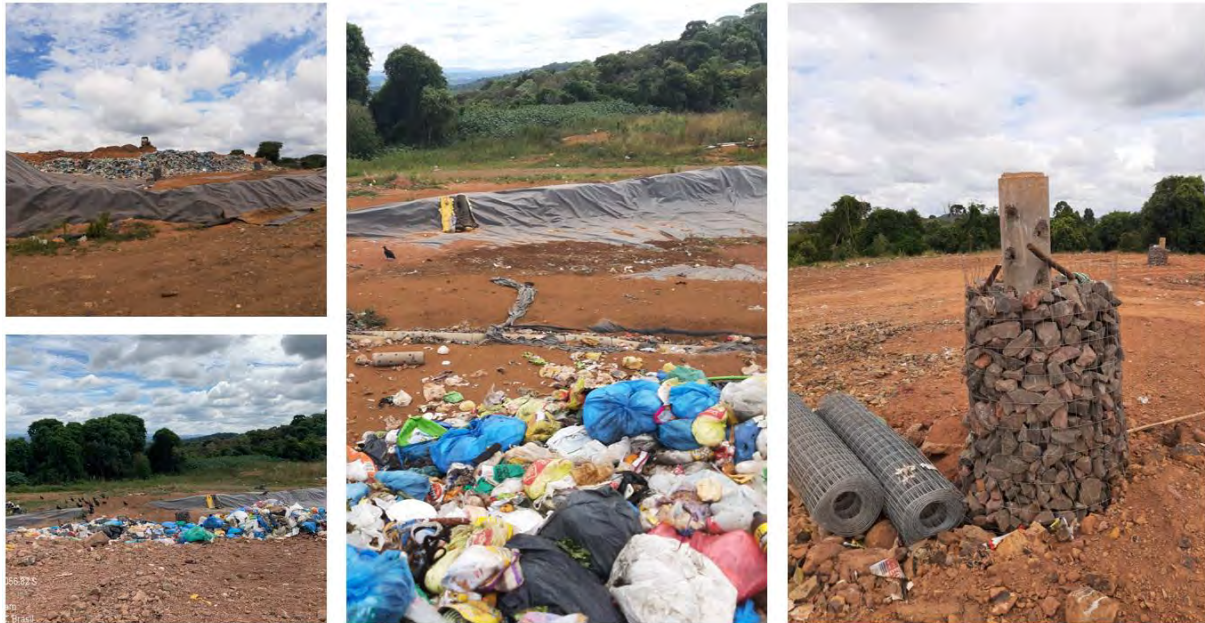
Figura 191: Frente de operação do aterro operado pela SANEFRAI – em 01/2022.
