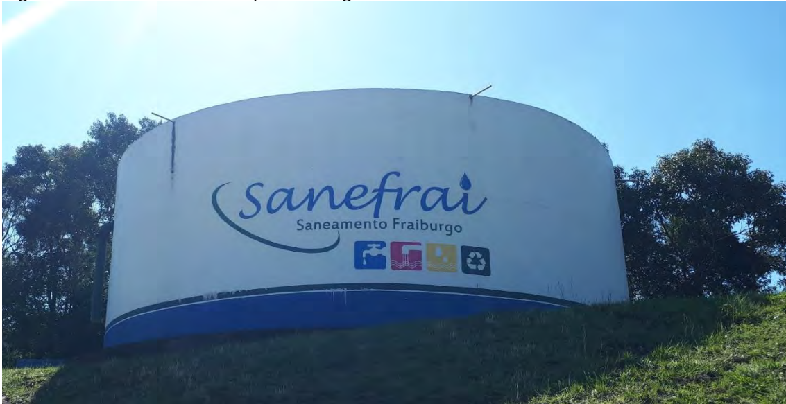
Figura 118: Centro de reservação São Miguel - 10/2022.
