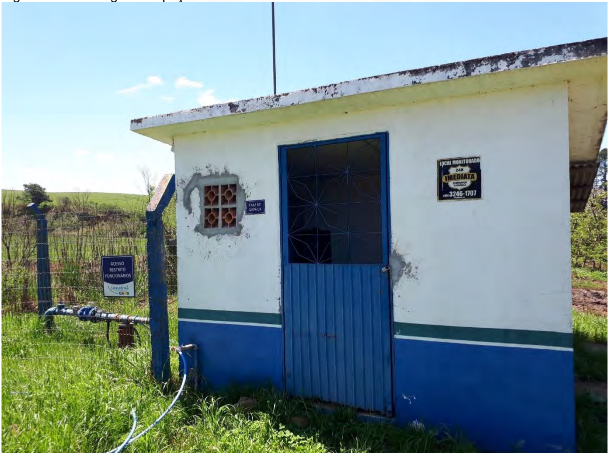
Figura 114: Visão geral do poço P10 - 10/2022.
