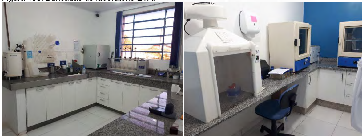
Figura 155: Bancadas do laboratório ETA.
