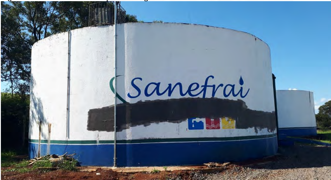
Figura 119: Centro de reservação São Miguel - 10/2022.
