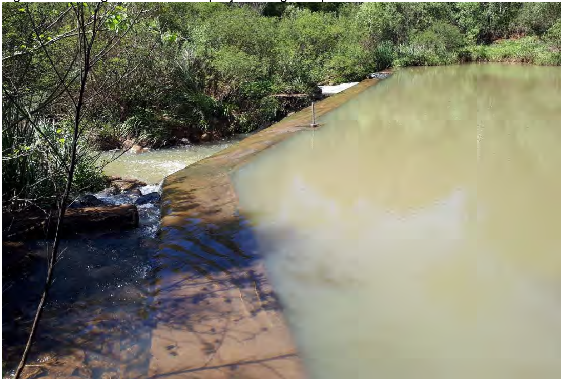
Figura 30: Barragem de nível - Captação de água superficial - Rio Mansinho -10/2022.
