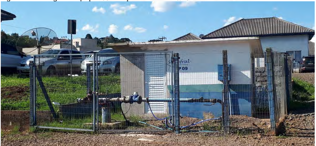
Figura 72: Visão geral do poço P09 – Poço Vila Salete -10/2022.
