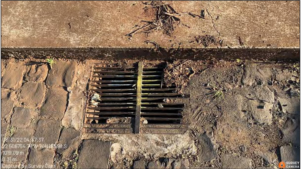
Figura 306: Boca de lobo da AP-18 – 08/2022.
