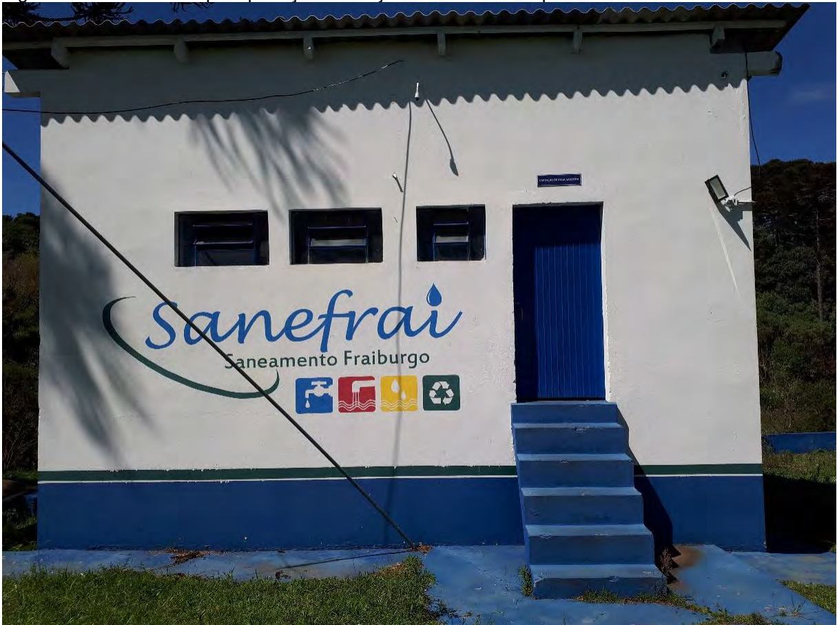
Figura 31: Estrutura civil para proteção do conjunto motobomba e painel -10/2022.
