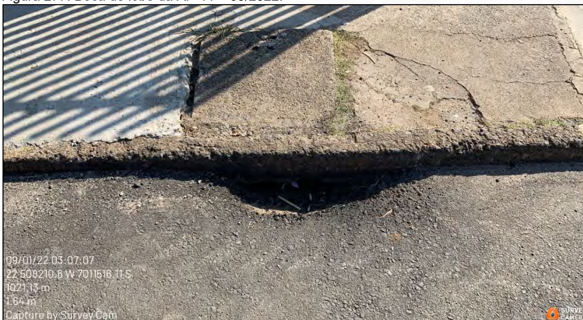
Figura 277: Boca de lobo da AP-11 – 09/2022.
