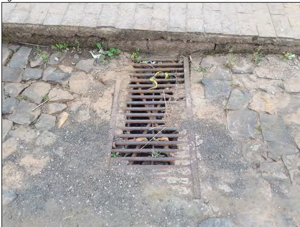
Figura 249: Boca de lobo - AP-4 – 09/2022.
