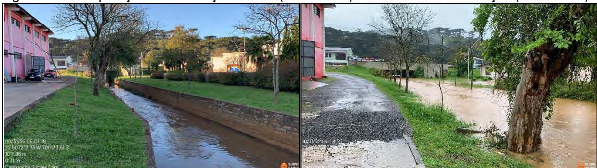
Figura 297: Comparação entre situação normal (31/08/2022) e em evento de inundação (11/10/2022).
