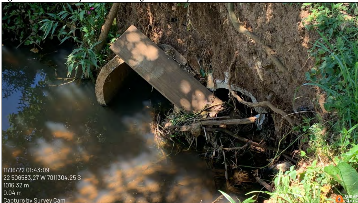
Figura 286: Canalização do curso d'água – tubulação de entrada – 11/2022.
