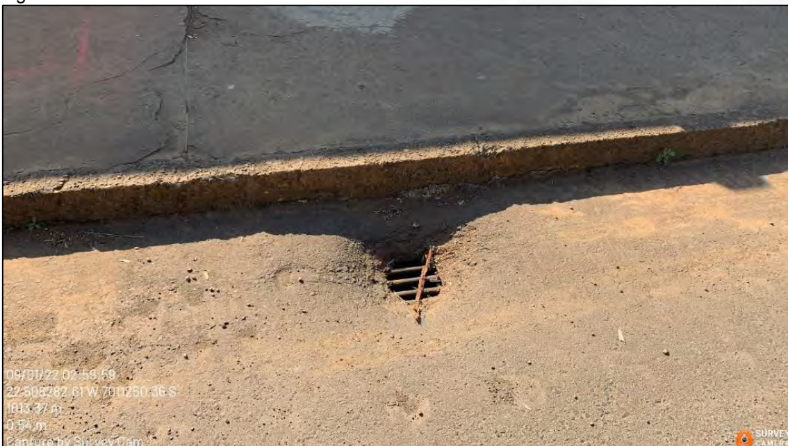
Figura 242: Boca de Lobo - AP2 – 09/2022.
