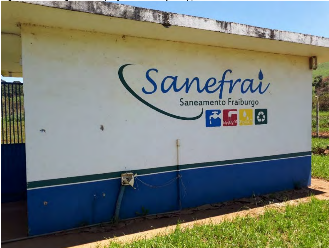
Figura 108: Visão geral da captação P07 – Poço Tieppo - 10/2022.
