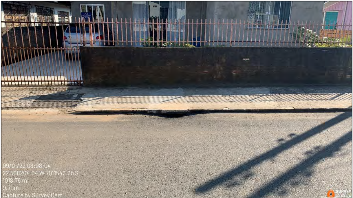
Figura 278: Boca de lobo da AP-11 – 09/2022.
