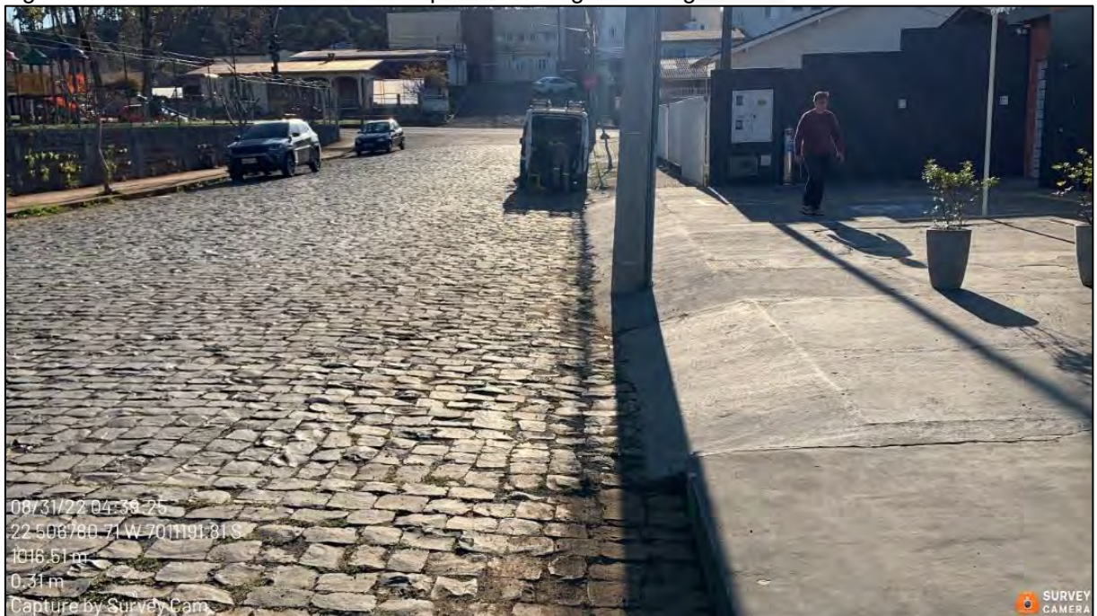
Figura 305: Entrada elevada construída para conter água de alagamentos – 08/2022.
