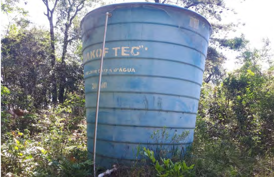
Figura 120: Centro de reservação São Cristóvão - 10/2022.
