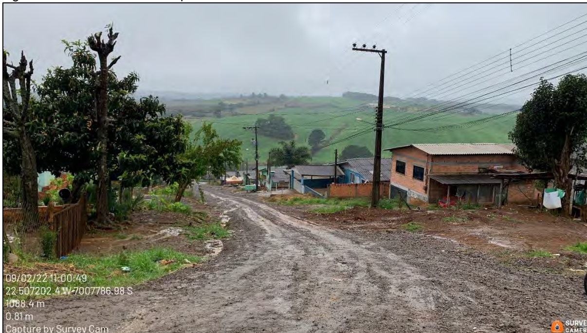
Figura 322: Trecho da rua não pavimentado – 09/2022.
