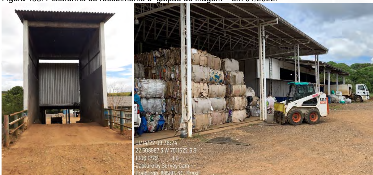
Figura 193: Plataforma de recebimento e galpão de triagem – em 01/2022.
