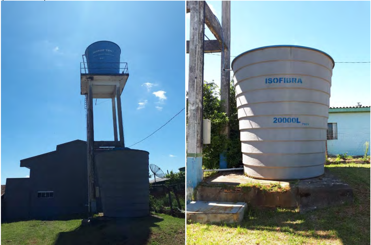
Figura 130: Centro de Reservação Macieira - Reservatório elevado (ativo) e reservatório apoiado (desativado) - 10/2022.
