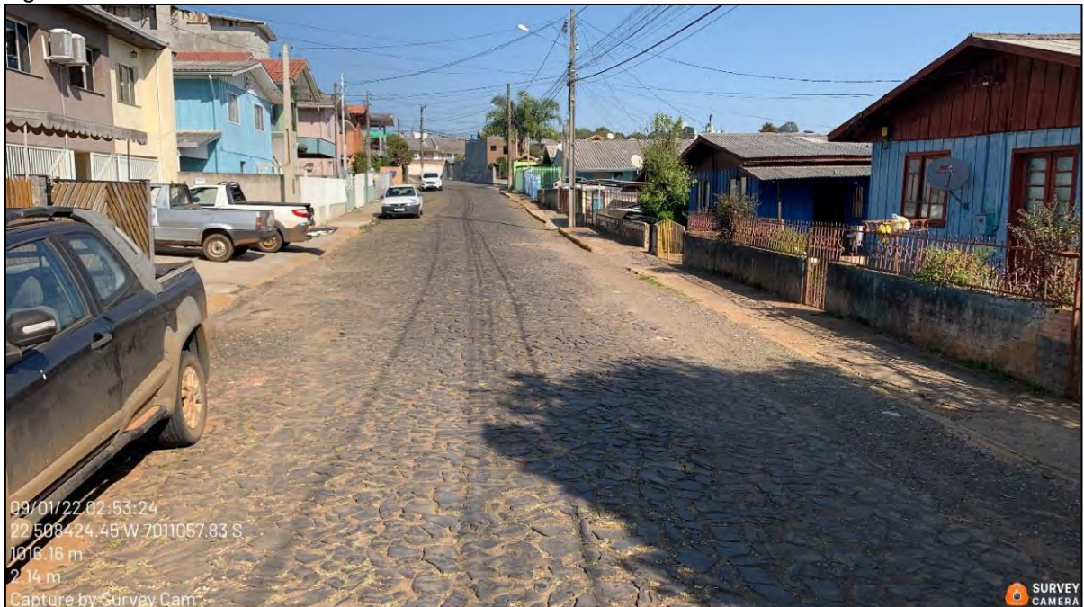
Figura 264: Acúmulo de sedimentos na via – 09/2022.
