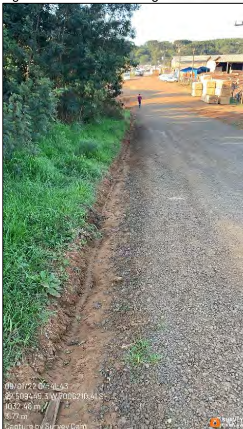
Figura 246: Vala de drenagem construída na AP-3 – 09/2022.
