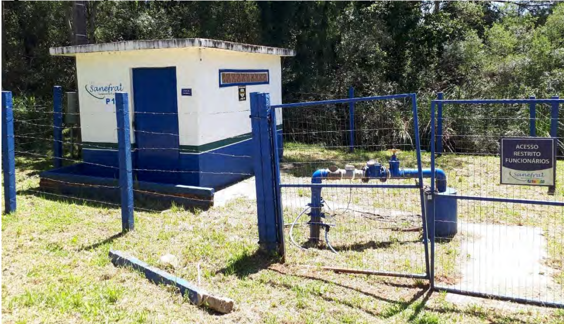
Figura 84: Visão geral do poço P14 – Poço Portal II -10/2022.
