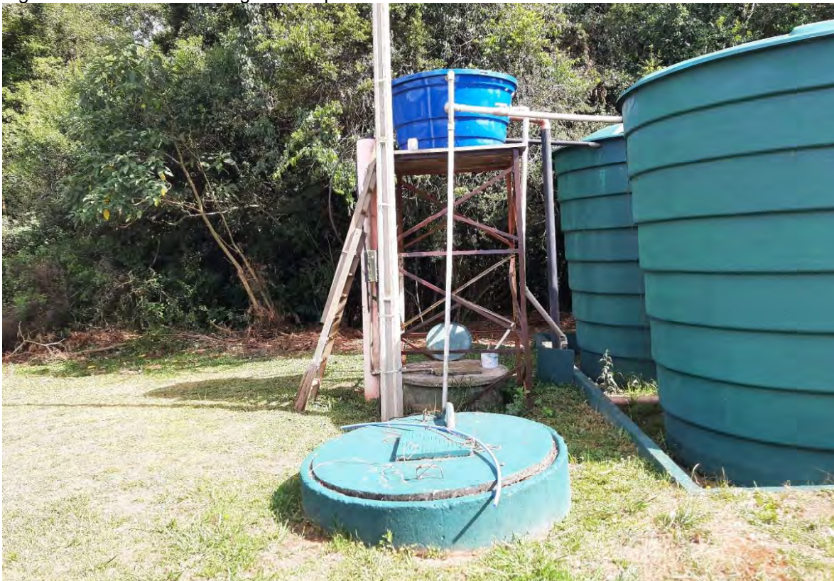
Figura 165: Elevatória da segunda etapa do tratamento – 01/2022.
