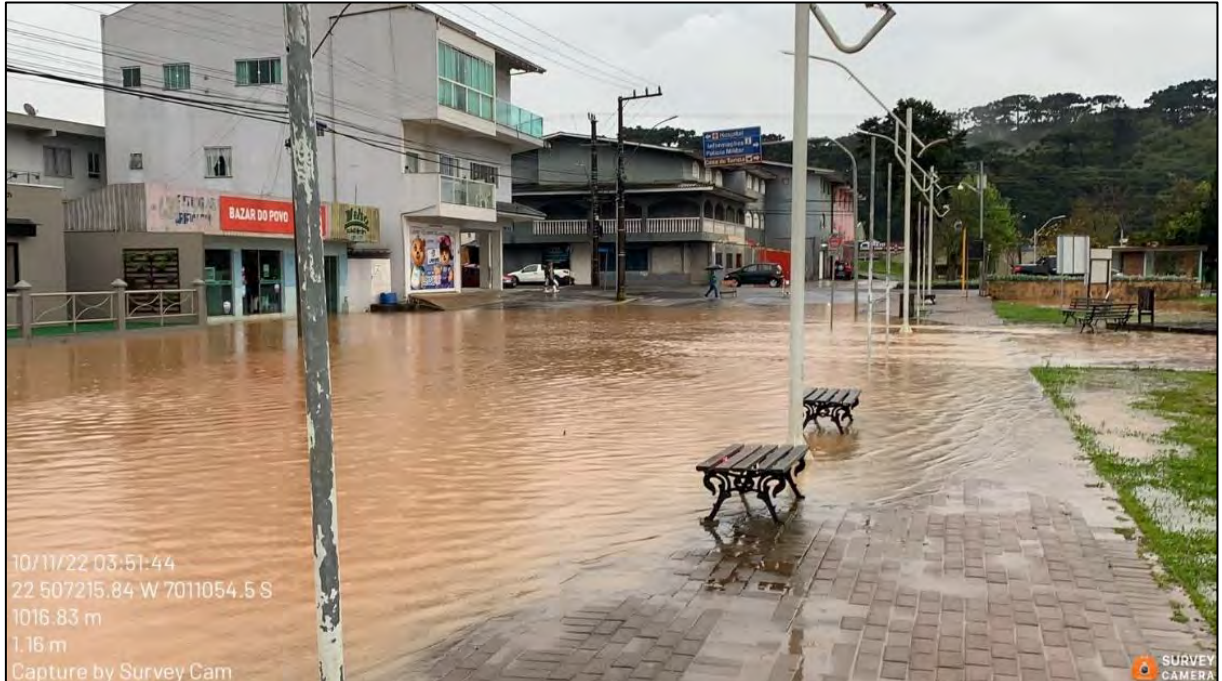
Figura 293: Evento de inundação na AP-15 – 10/2022.
