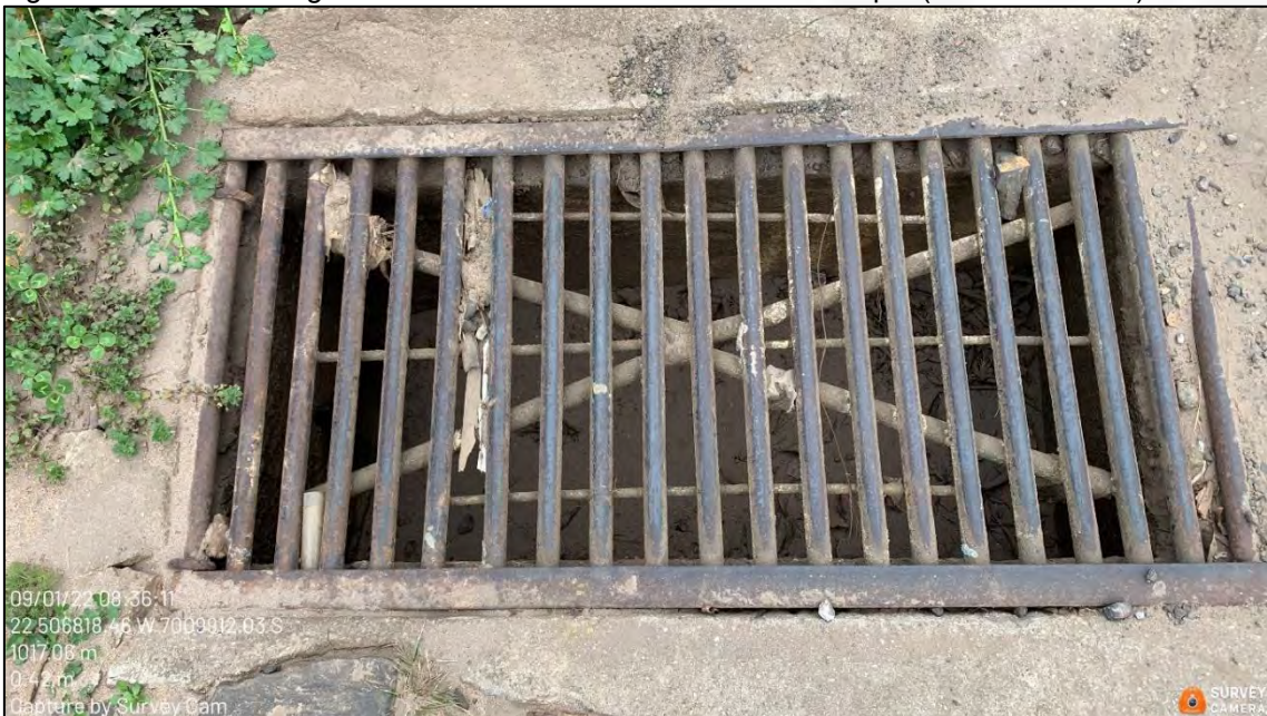
Figura 233: Modelo de grelha de boca de lobo existente no município (Rua 21 de Abril).
