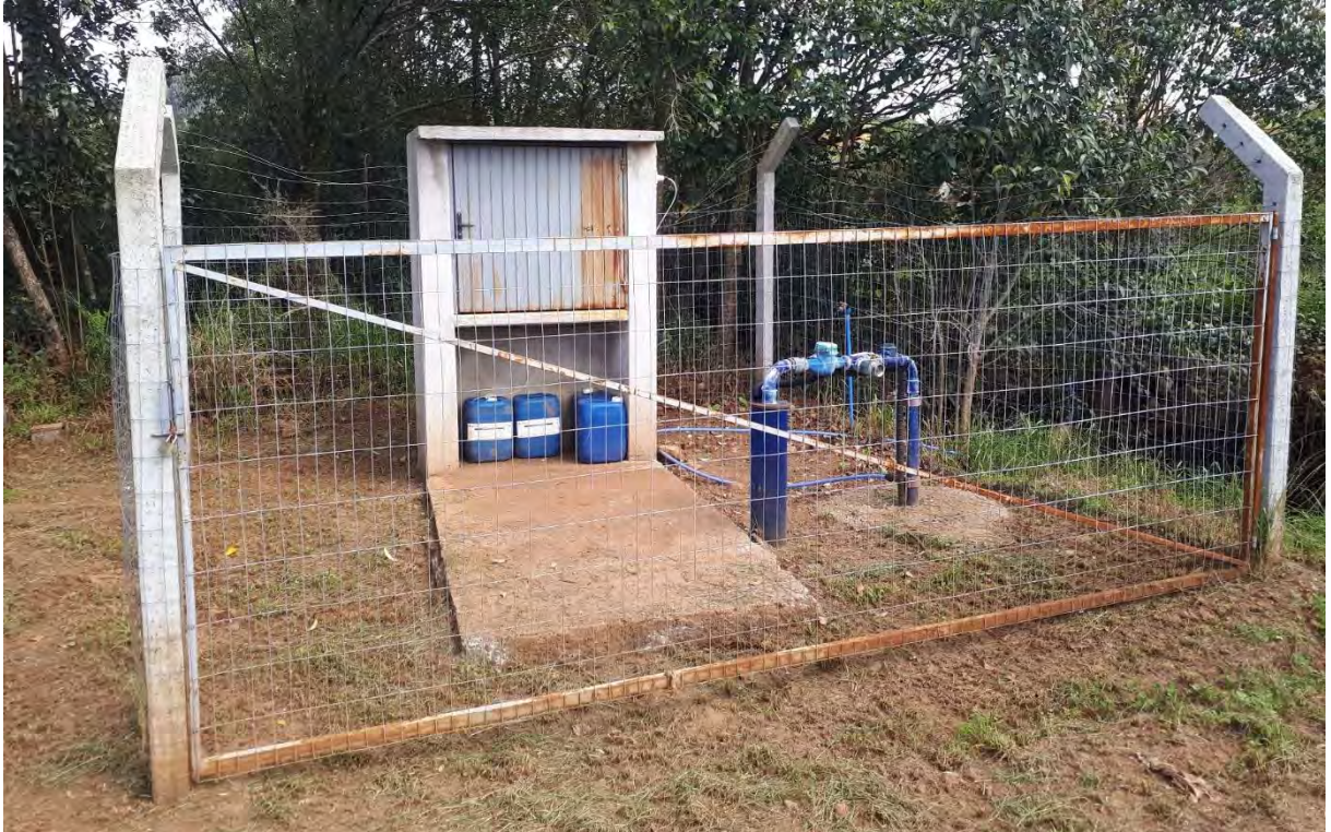
Figura 87: Visão geral do Poço P18 -10/2022.
