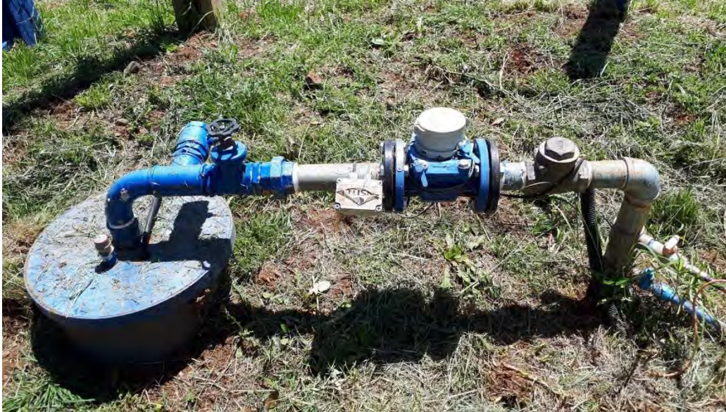
Figura 81: Cavalete P13 – Poço Portal I - 10/2022.
