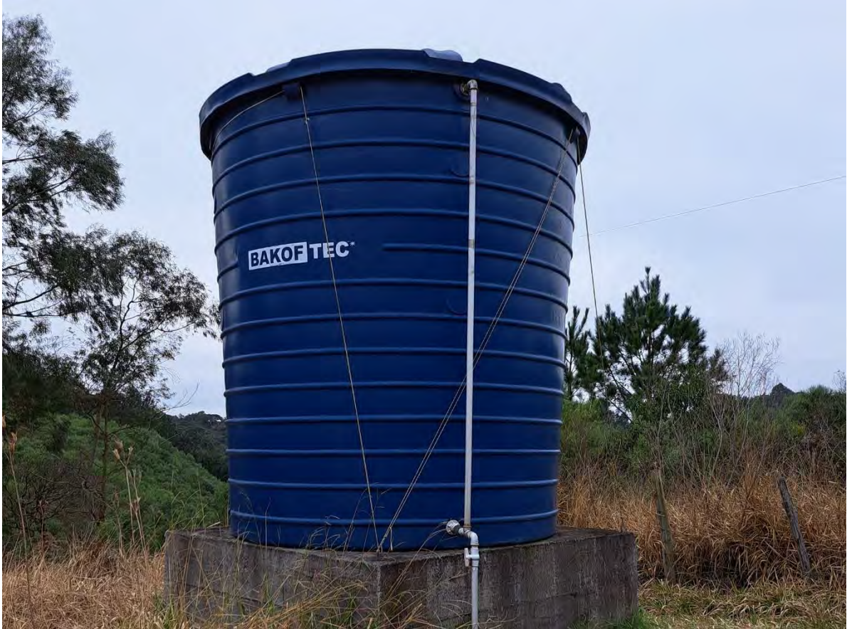
Figura 148: Centro de reservação do SAA X de novembro – tanques em polietileno - 10 m³ - 07/2024.
