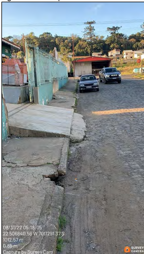
Figura 272: Rampas construídas em área de sarjeta – 08/2022.
