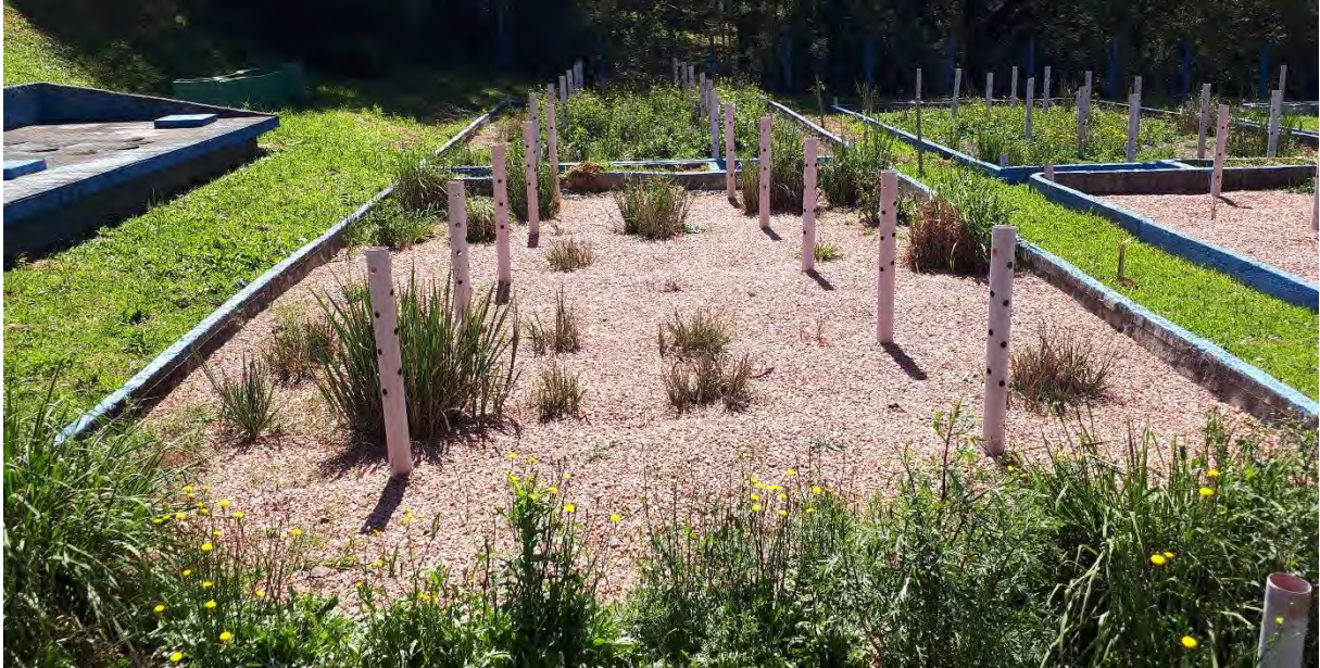
Figura 173: Sistema de Wetlands de fluxo horizontal – 10/2022.
