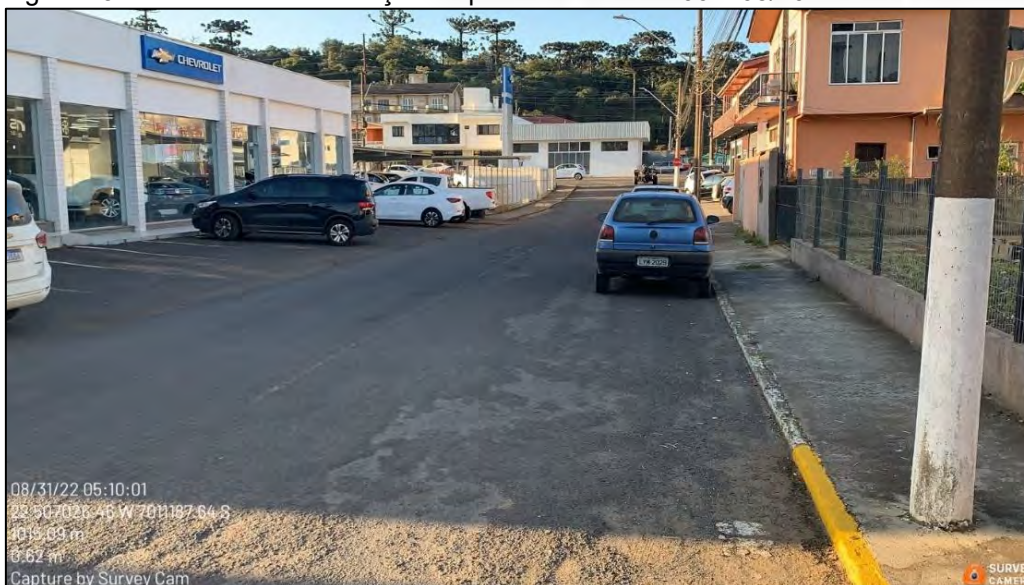
Figura 254: Estado de conservação do pavimento na AP-06 – 08/2022.
