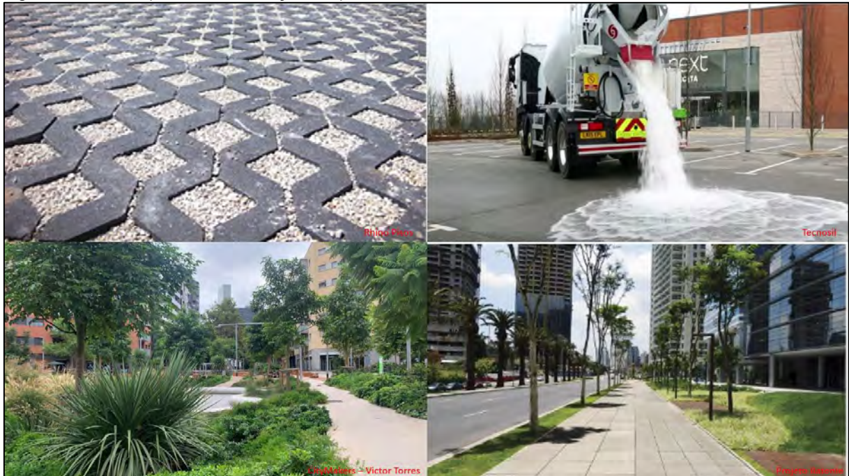
Figura 332: Exemplos de valorização da permeabilidade dos solos.
