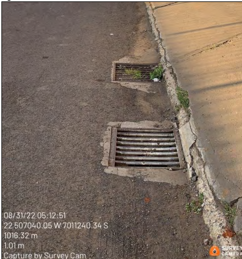
Figura 255: Bocas de lobo da AP-06 – 08/2022.
