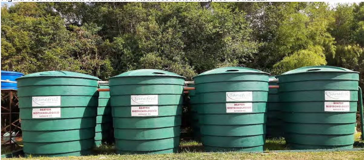
Figura 166: Tratamento secundário – Reatores biotecnológicos – 01/2022.
