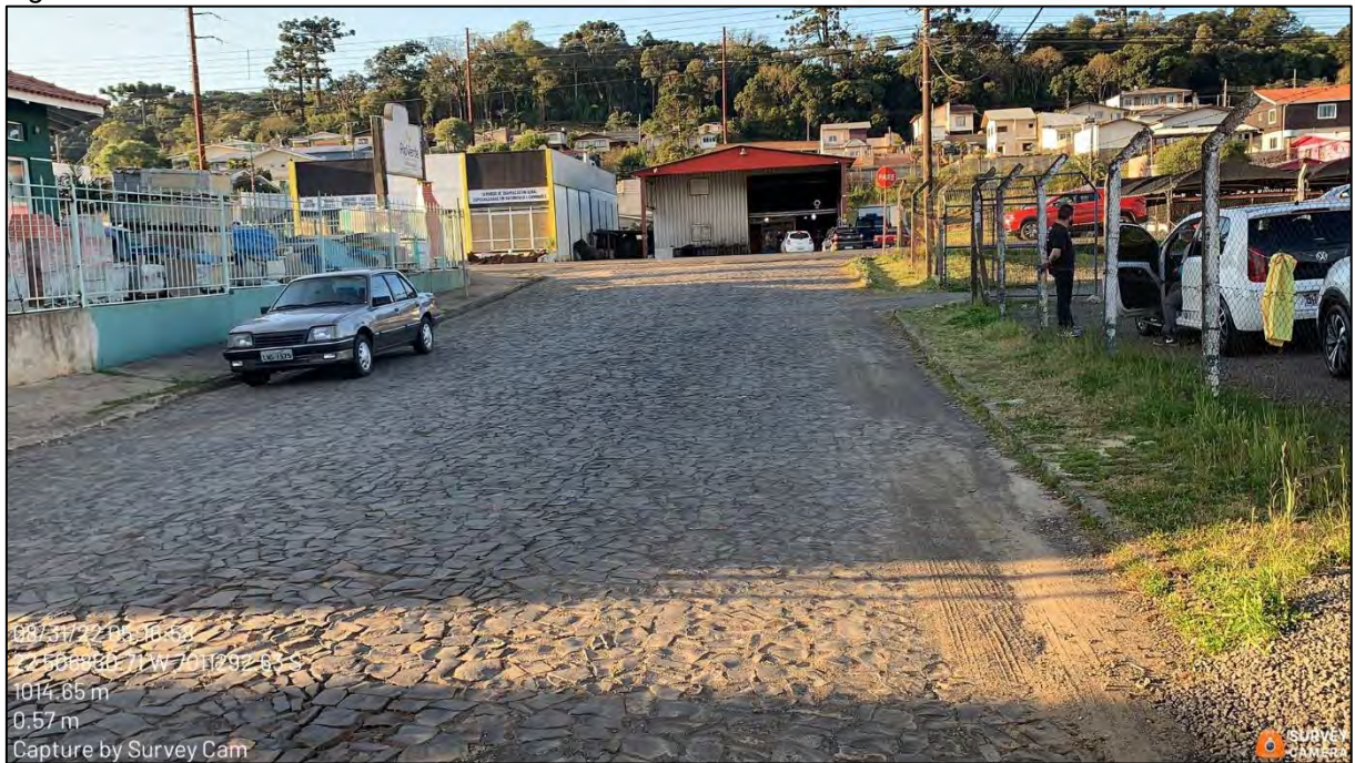
Figura 269: Acúmulo de sedimentos na via – 08/2022.
