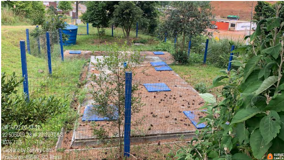
Figura 178: ETE São Sebastião II - Reatores anaeróbios e filtro anaeróbio – 01/2022.
