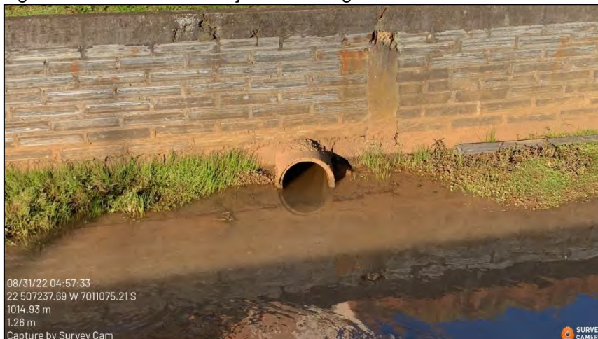
Figura 292: Saída de tubulação de drenagem no Arroio da Ameixa – 08/2022.
