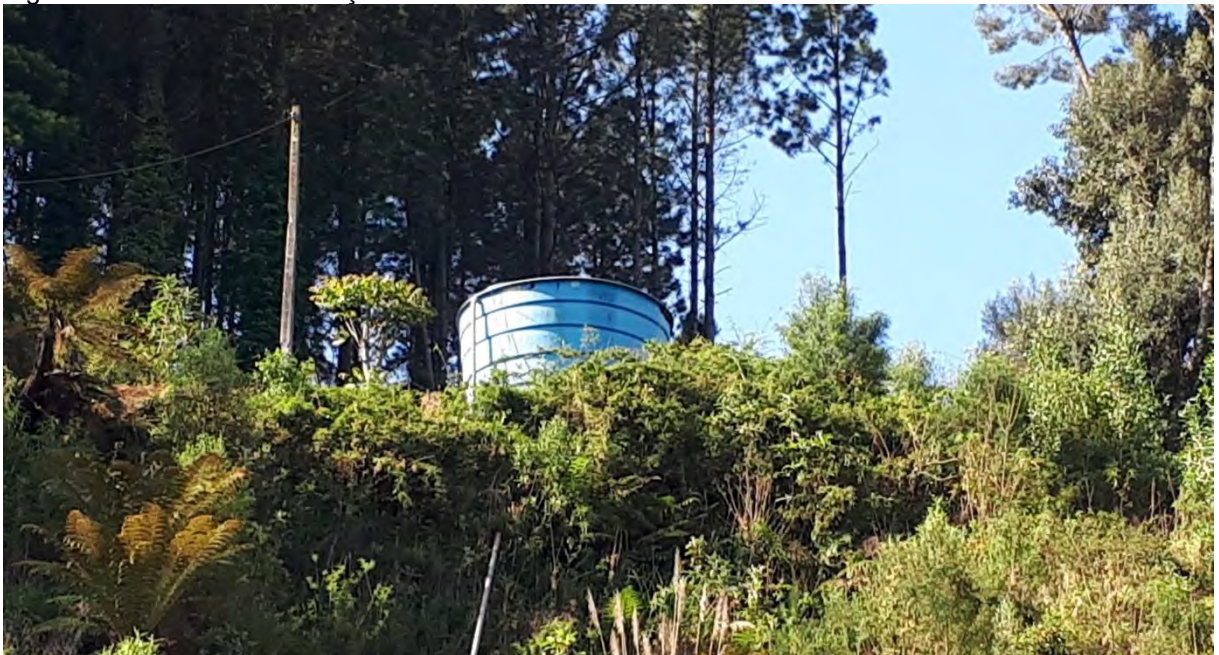
Figura 92: Centro de reservação Vila Nova – Reservatório Vila Nova - 10/2022.
