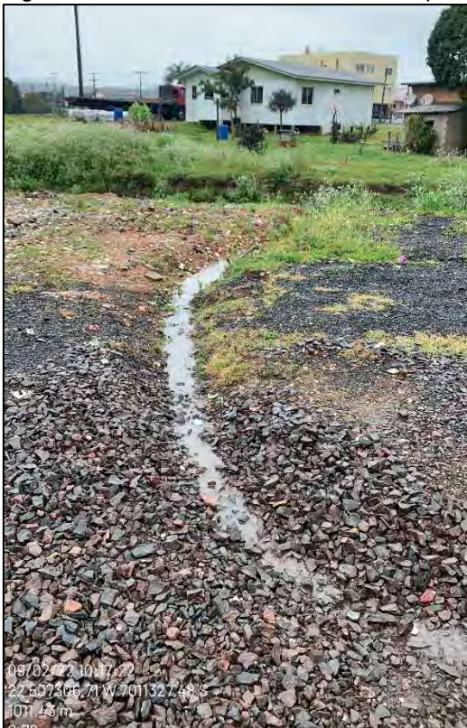
Figura 328: Vala rudimentar construída para escoamento da água – 09/2022.
