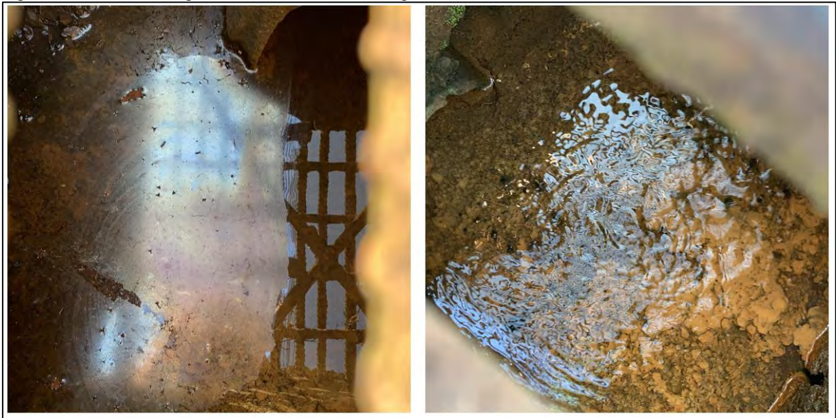
Figura 280: Fluxo de água e acúmulo de óleos e graxas – 09/2022.
