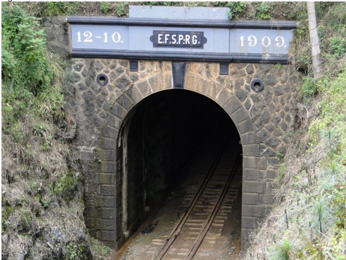
Figura 7 - Túnel ferroviário em Pinheiro Preto.
