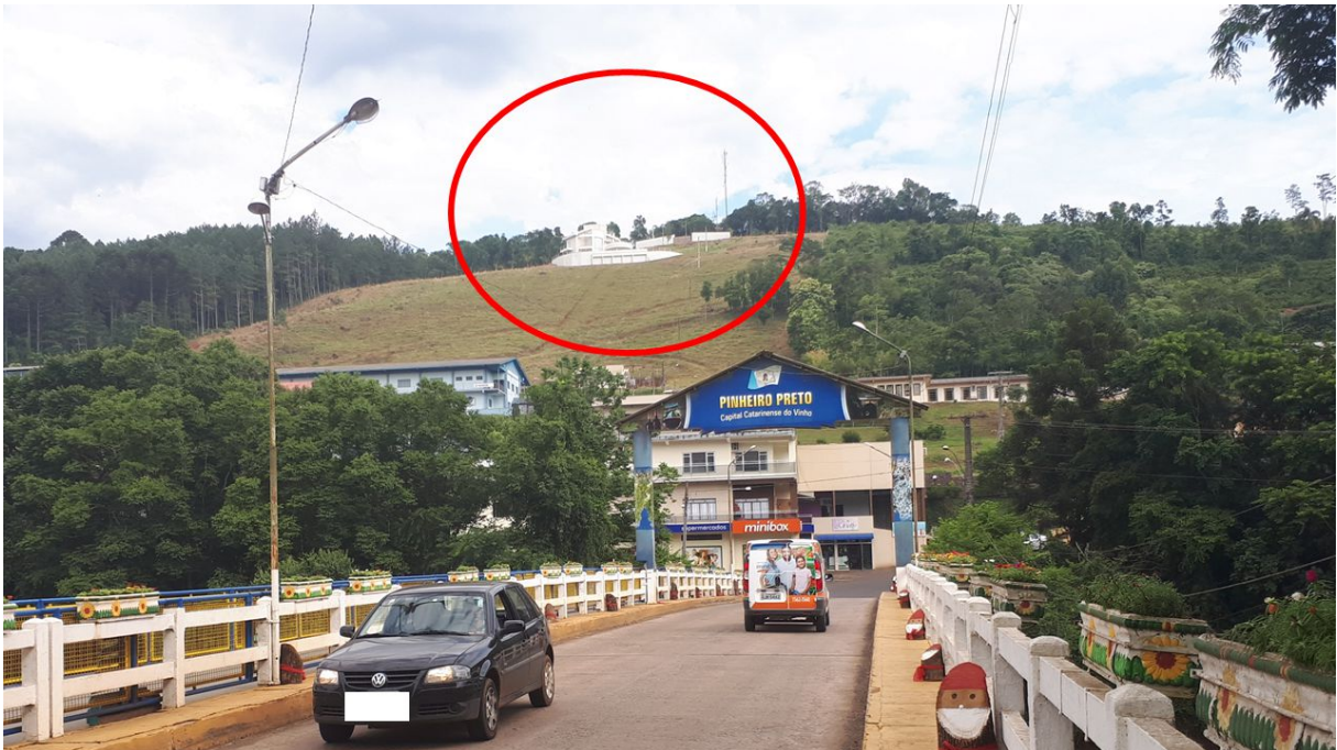
Figura 3 – Impacto na paisagem, causado por edificação, sem urbanização e tratamento paisagístico em seu entorno.
