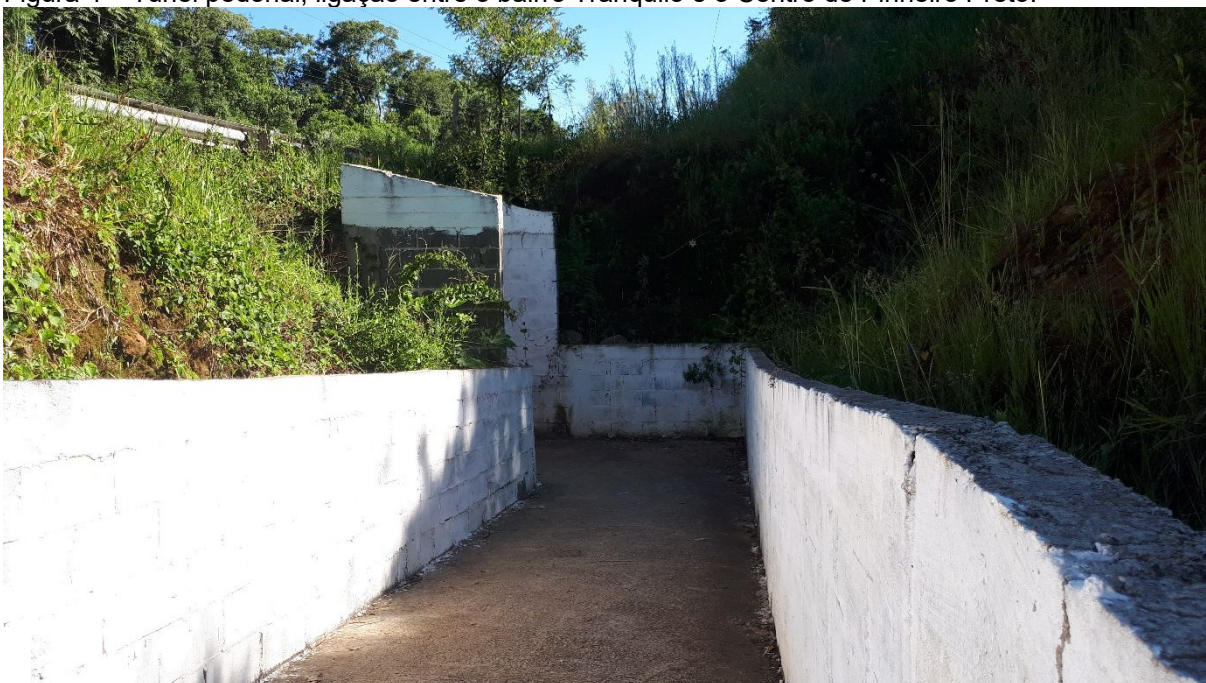
Figura 4 – Túnel pedonal, ligação entre o bairro Tranquilo e o Centro de Pinheiro Preto.
