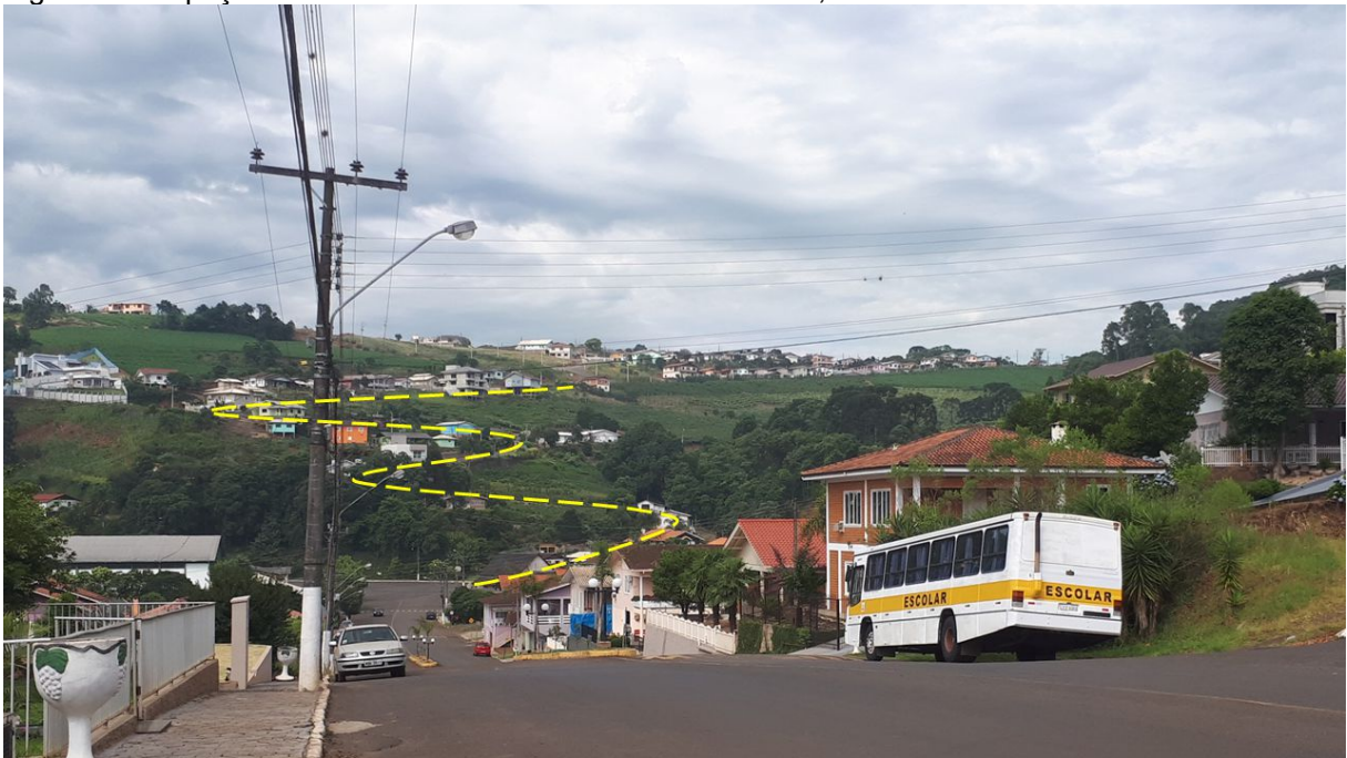
Figura 1- Ocupações entorno da Rua Antônio Costenaro Filho, acesso ao bairro São José.
