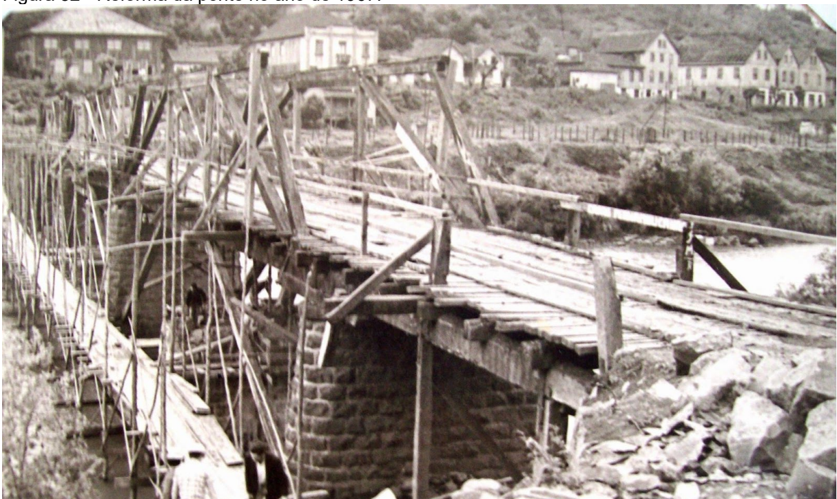
Figura 52 - Reforma da ponte no ano de 1967.
