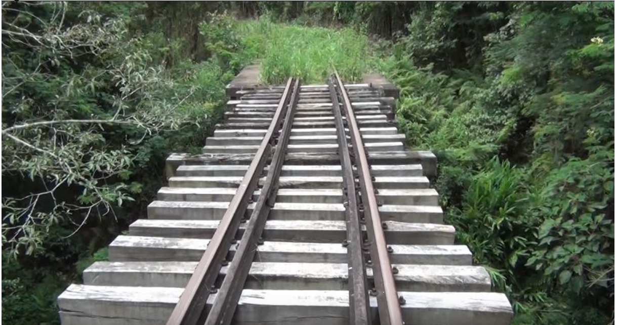
Figura 104 - Pontilhão do Arroio da Cruz em Pinheiro Preto.
