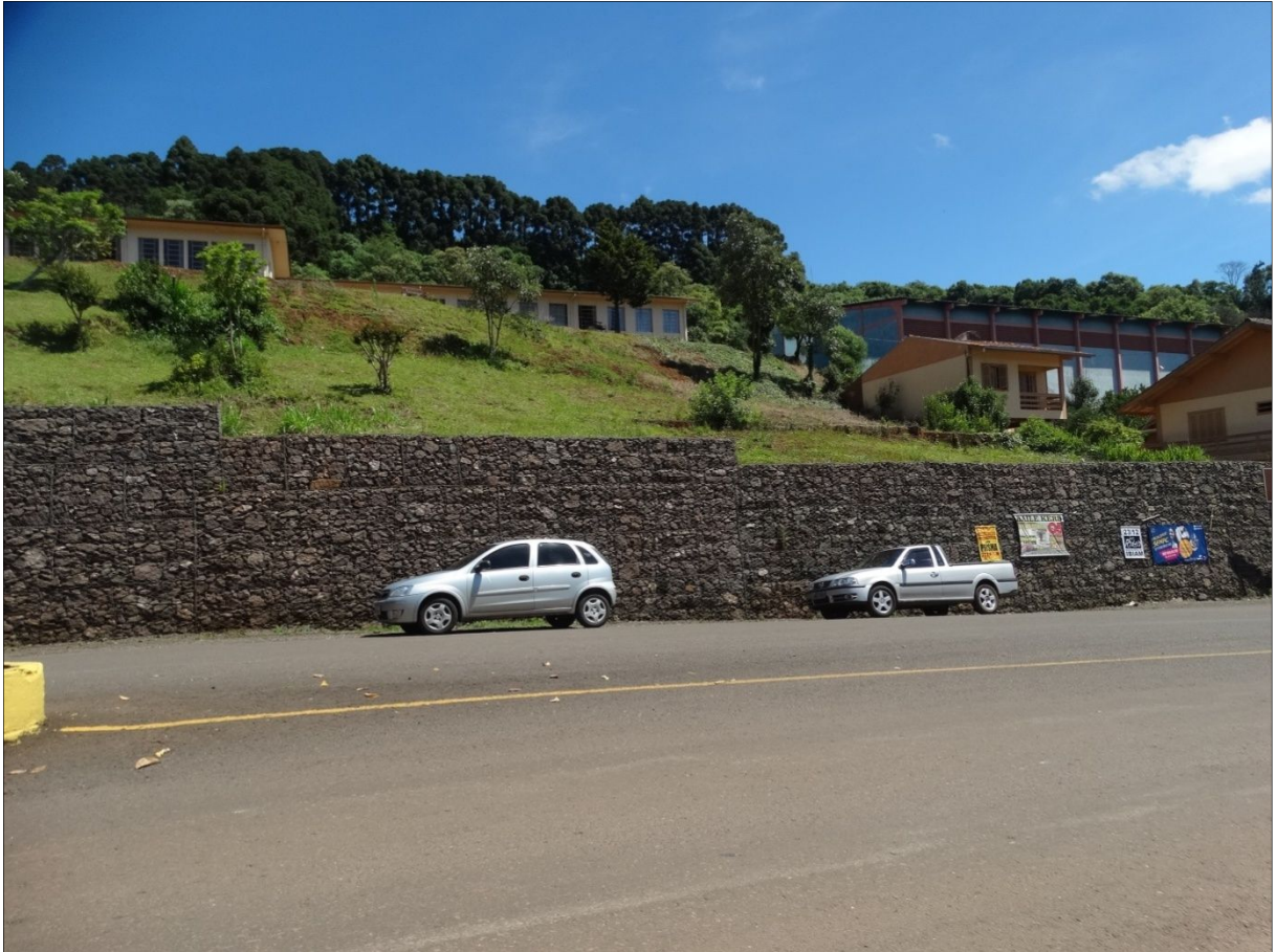
Figura 30 - Muro de contenção construído para conter o talude.
