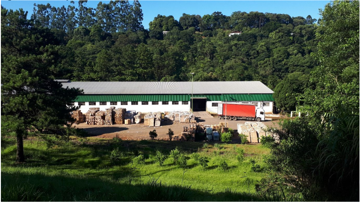
Figura 74 - Edificação Industrial na SC-135, bairro Vila Bressan.
