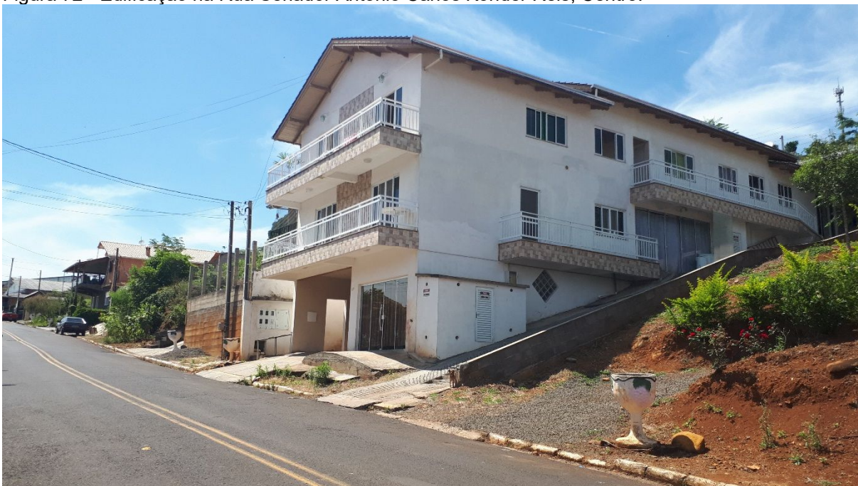
Figura 72 - Edificação na Rua Senador Antônio Carlos Konder Reis, Centro.
