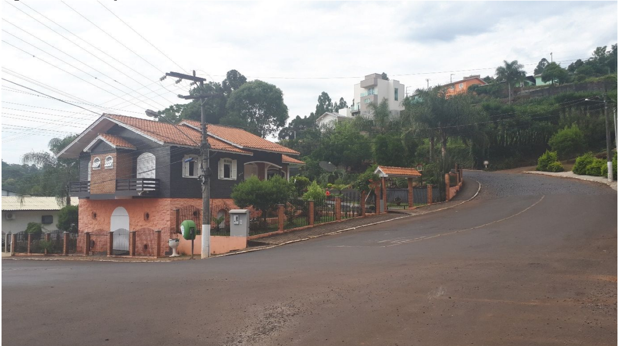
Figura 78 - Edificações na Rua Antônio Costenaro Filho, Centro.
