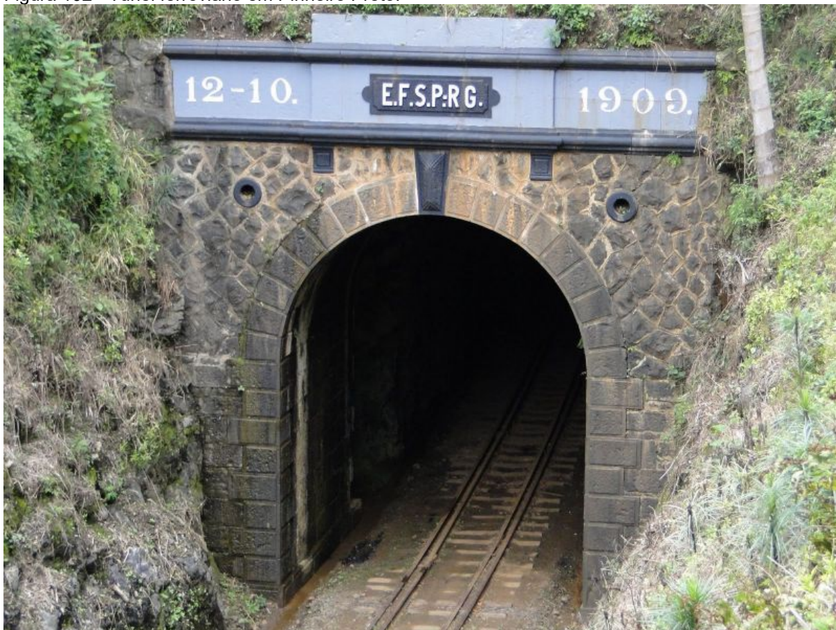
Figura 102 - Túnel ferroviário em Pinheiro Preto.
