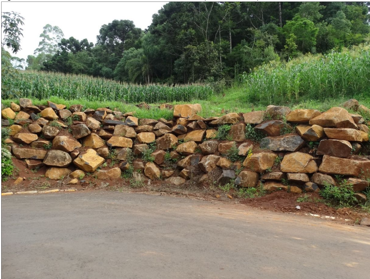
Figura 27 - Parede construída com blocos rochosos, no ponto 8 do Mapa de Fotos.
