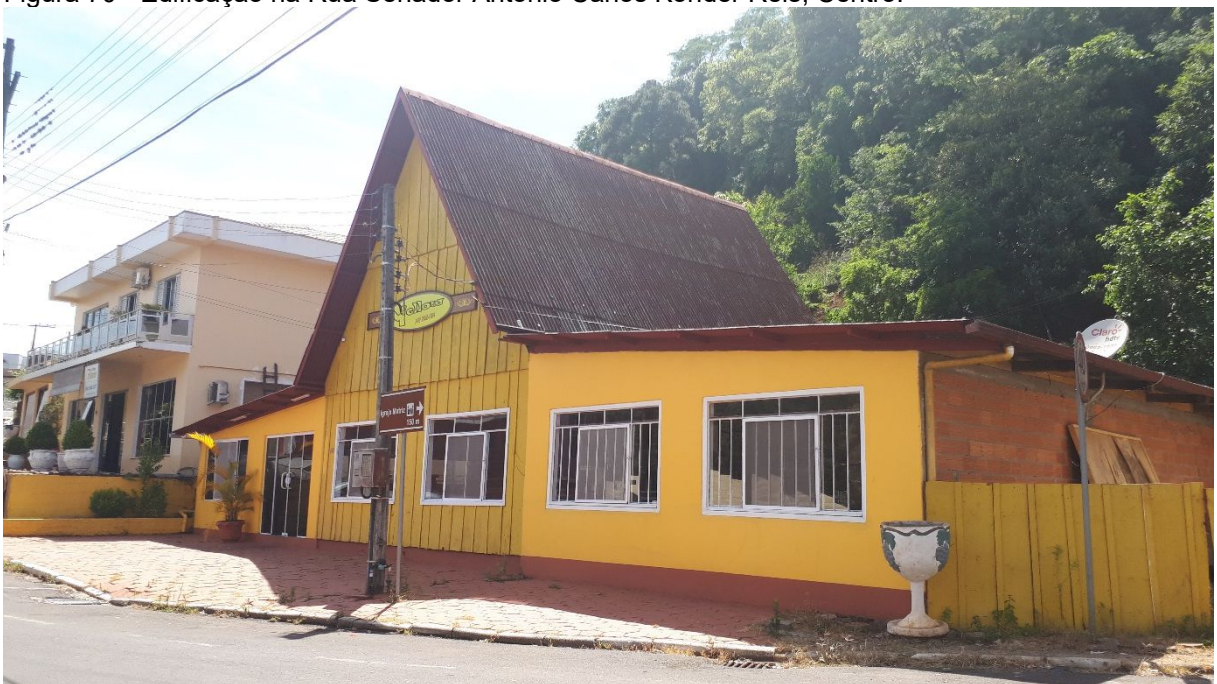
Figura 70 - Edificação na Rua Senador Antônio Carlos Konder Reis, Centro.
