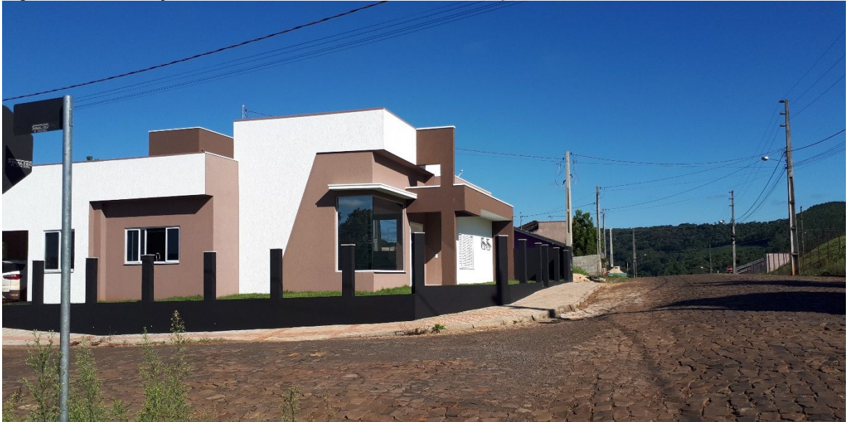
Figura 82 - Edificação na Rua Avelino Bressan, bairro Tranquilo Guzzi.
