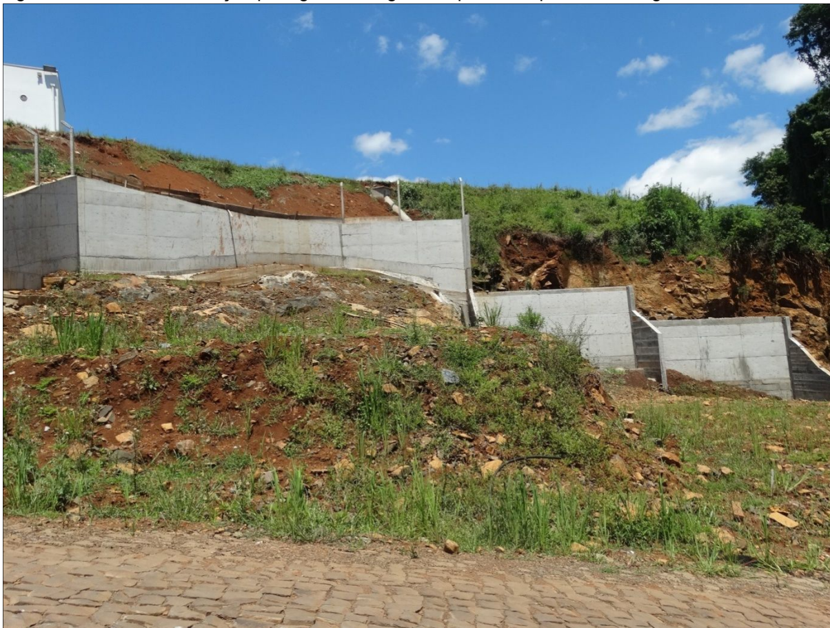
Figura 34 - Muro de contenção protegendo a região, no ponto 7, apontada na Figura 33.
