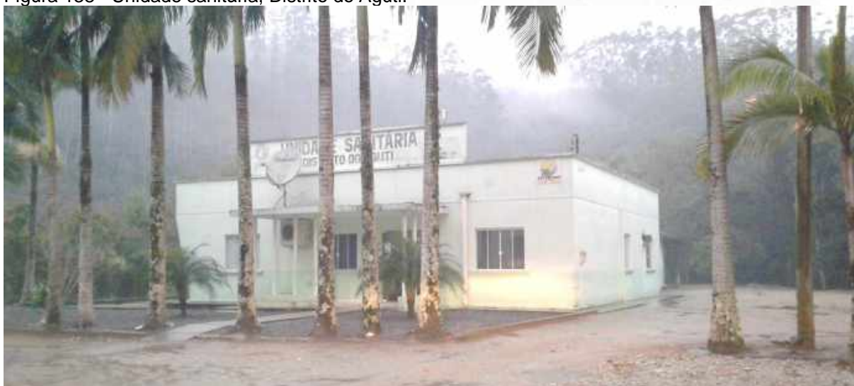
Figura 138 - Unidade sanitária, Distrito do Aguti.
