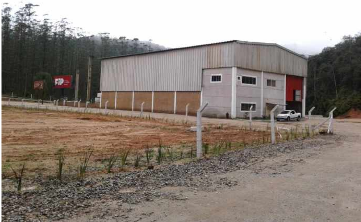
Figura 144 – Barracão, via sem nome, próxima a SC-410, saída para Brusque.
