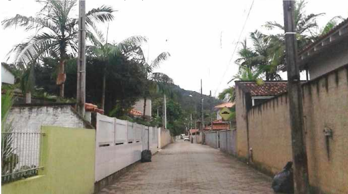
Figura 386 – Falta de infraestrutura para pedestres na Rua José Gandin, Trinta Réis, Sede.
