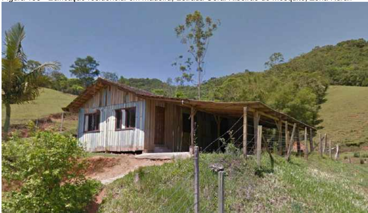
Figura 158 - Edificação residencial em madeira, Estrada Geral Ribeirão do Mosquito, Zona Rural.
