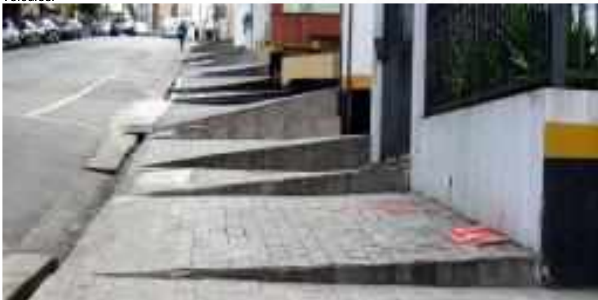
Figura 512 - Imagem da questão da utilização integral dos passeios para rampas de acessos de veículos.
