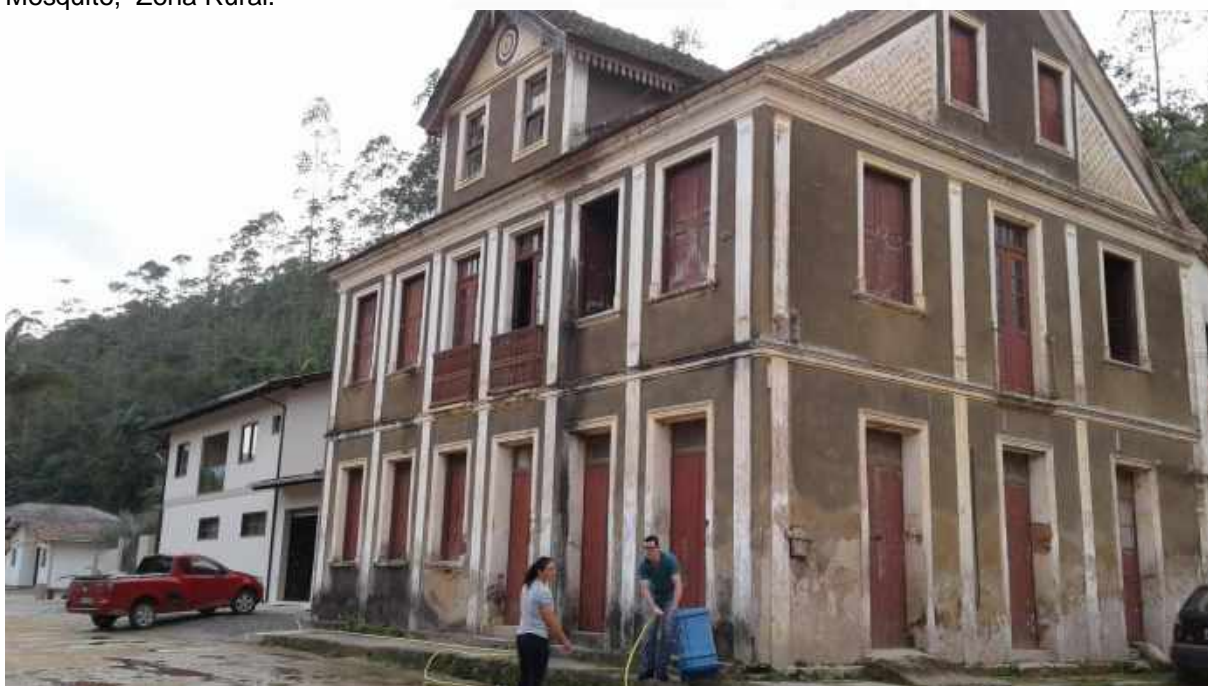
Figura 155 – Edificação no cruzamento Estrada Geral Salto Baixo e Estrada Geral do Ribeirão Mosquito, Zona Rural.
