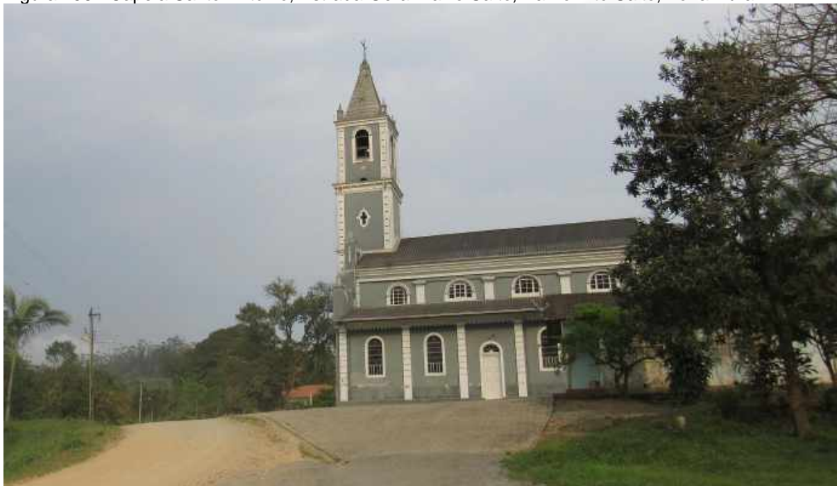
Figura 156 - Capela Santo Antônio, Estrada Geral Baixo Salto, Bairro Alto Salto, Zona Rural.
