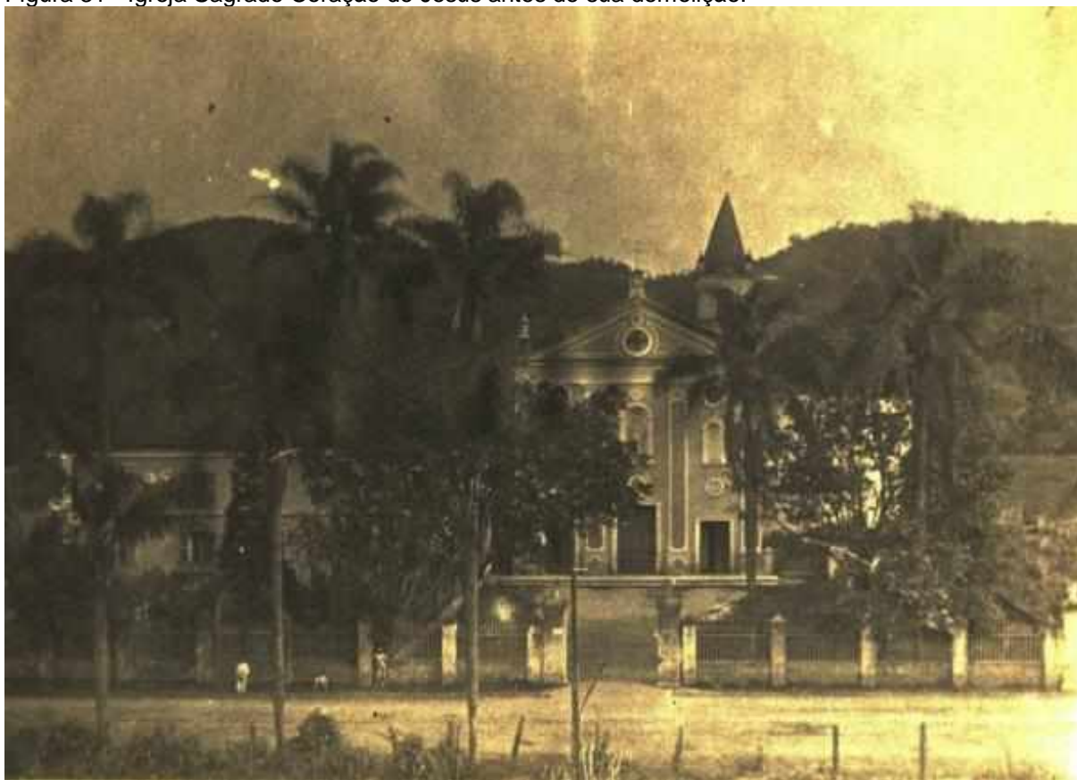
Figura 31 - Igreja Sagrado Coração de Jesus antes de sua demolição.
