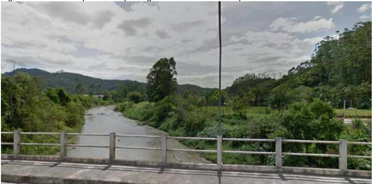
Figura 390 - Ponto do ponto B no prolongamento da Rua Clara Cipriani.
