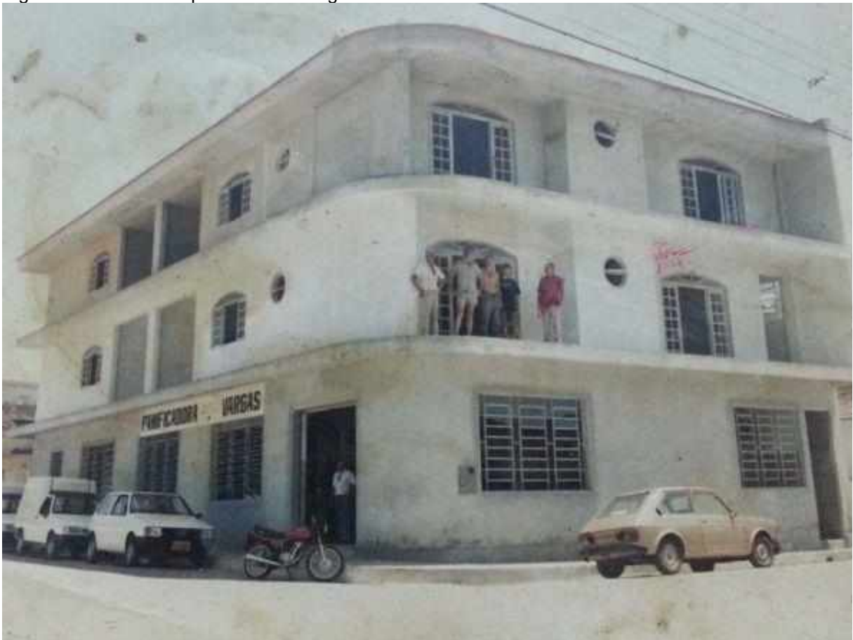
Figura 52 - Edifício da panificadora Vargas em Nova Trento.
