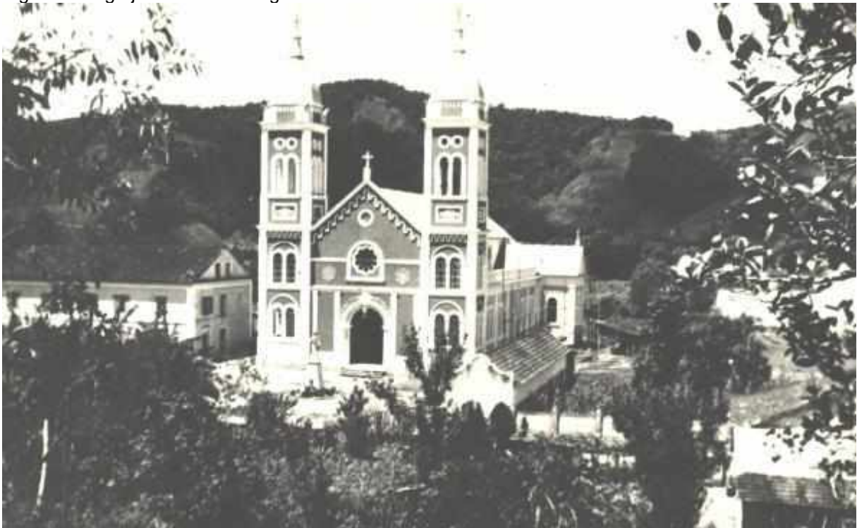
Figura 39 - Igreja Matriz São Virgílio em Nova Trento finalizada.
