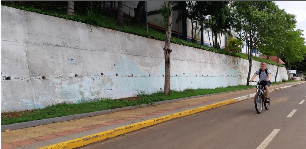
Figura 96 - Ciclista transitando na pista de rolamento
