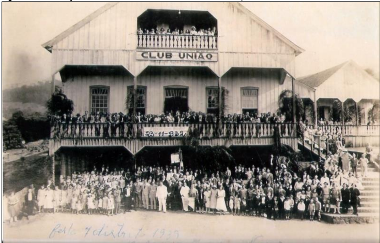
Figura 18 - Edificação do Club União na década de 1930, município de Piratuba
