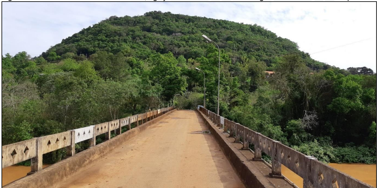
Figura 37 - Ponte sobre o Rio do Peixe, ligação entre o Distrito de Uruguai em Piratuba/SC e Ipira/SC
