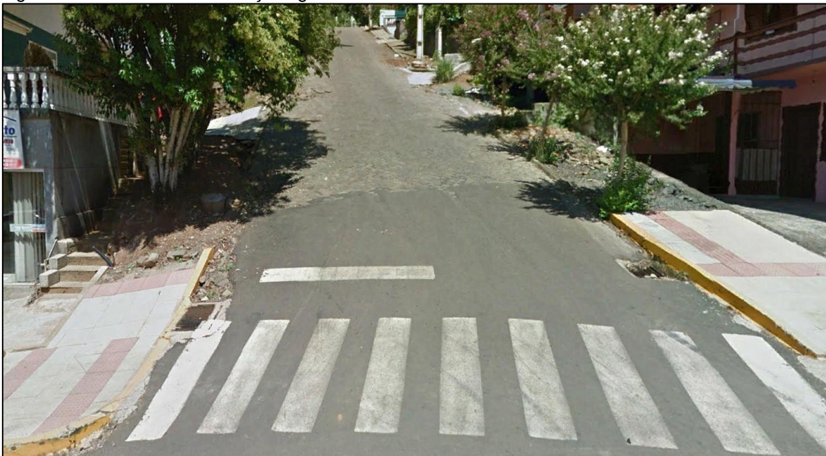
Figura 44 - Rua sem denominação ligando a avenida Dezoito de Fevereiro e a rua Boa Vista
