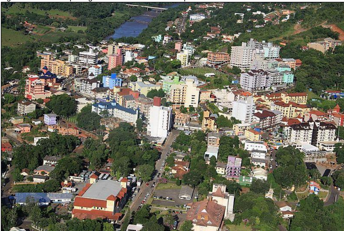
Figura 32 - Vista da paisagem urbana atual do município de Piratuba
