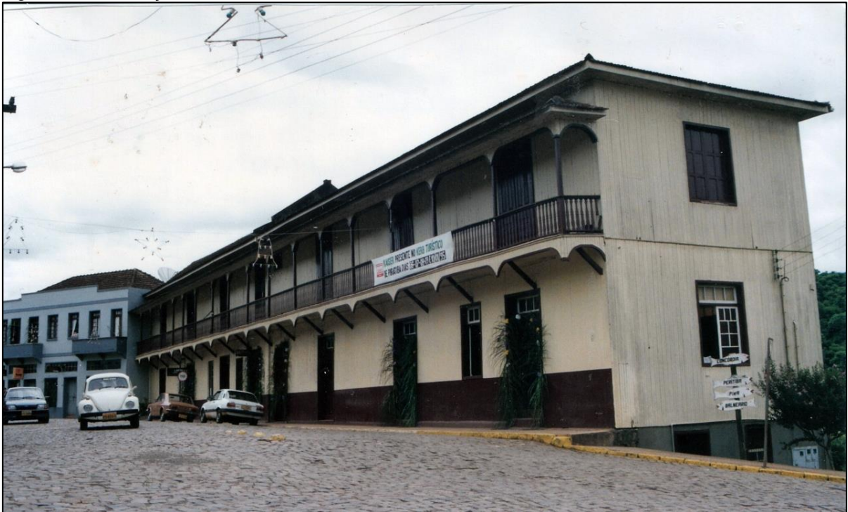
Figura 20 - Edificação em madeira construída na década de 1940
