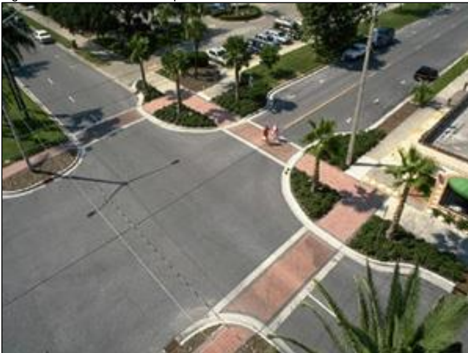
Figura 63 – Estreitamento de pista
