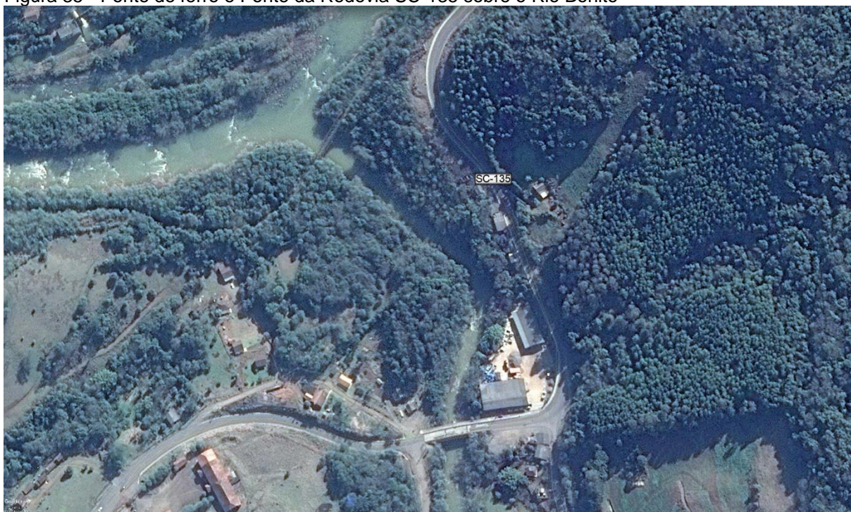
Figura 35 - Ponte de ferro e Ponte da Rodovia SC-135 sobre o Rio Bonito
