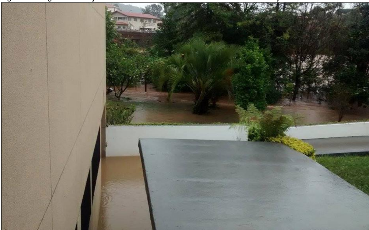
Figura 40 - Águas edificações da rua Padre Fridmundo no evento de inundação do dia 27/06/2014
