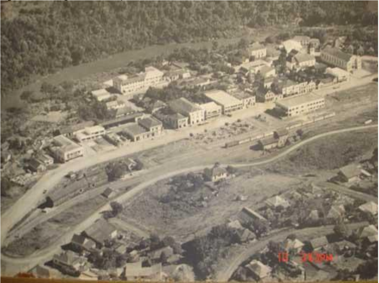
Figura 18 - Vista geral do município
