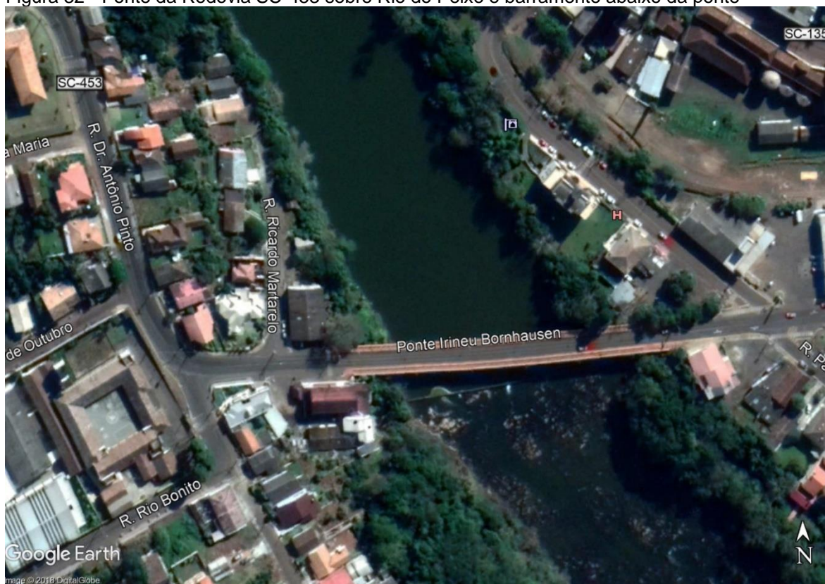
Figura 32 - Ponte da Rodovia SC-453 sobre Rio do Peixe e barramento abaixo da ponte
