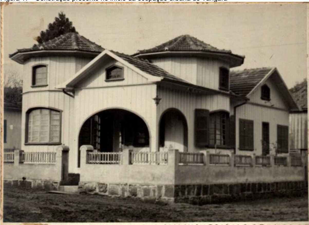
Figura 17 - Construção presente no início da ocupação urbana de Tangará
