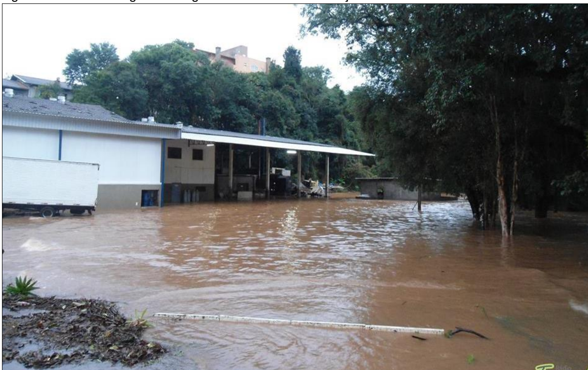
Figura 42 - Pátio do frigorífico Friguzzi no evento de inundação do dia 27/06/2014
