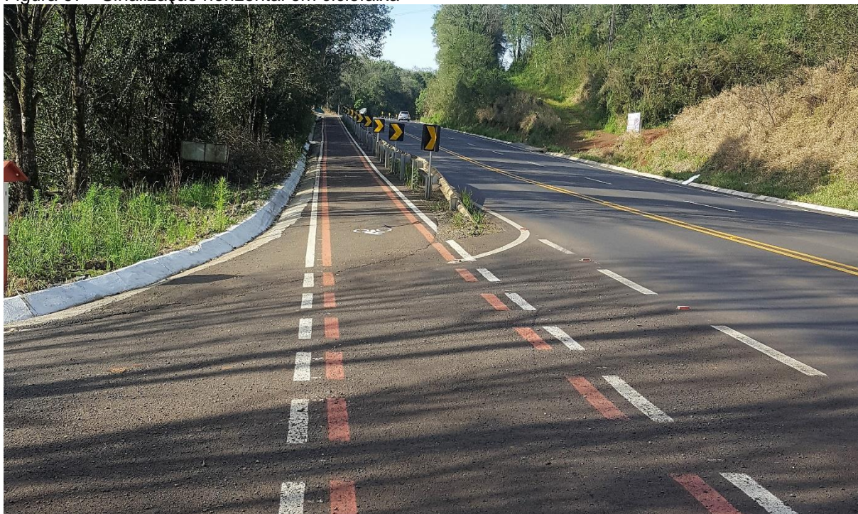
Figura 97 - Sinalização horizontal em ciclofaixa
