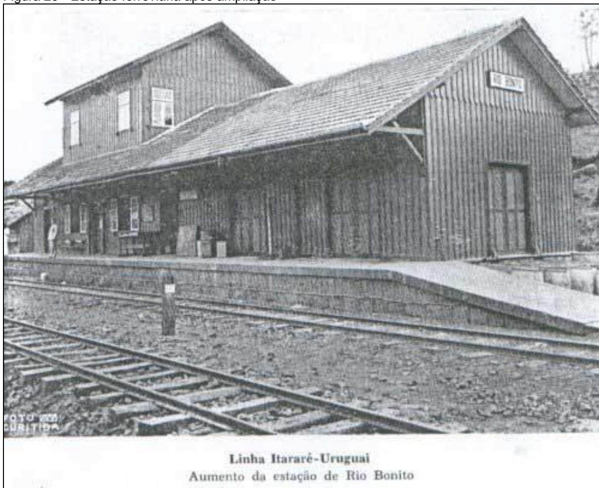
Figura 20 - Estação ferroviária após ampliação
