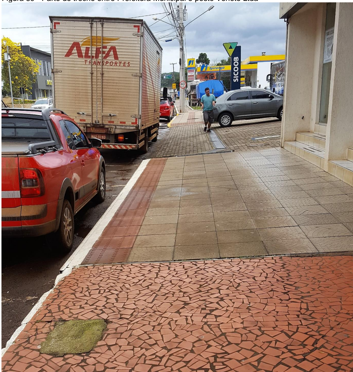
Figura 89 - Parte de trecho entre Prefeitura Municipal e posto Veneto Ltda
