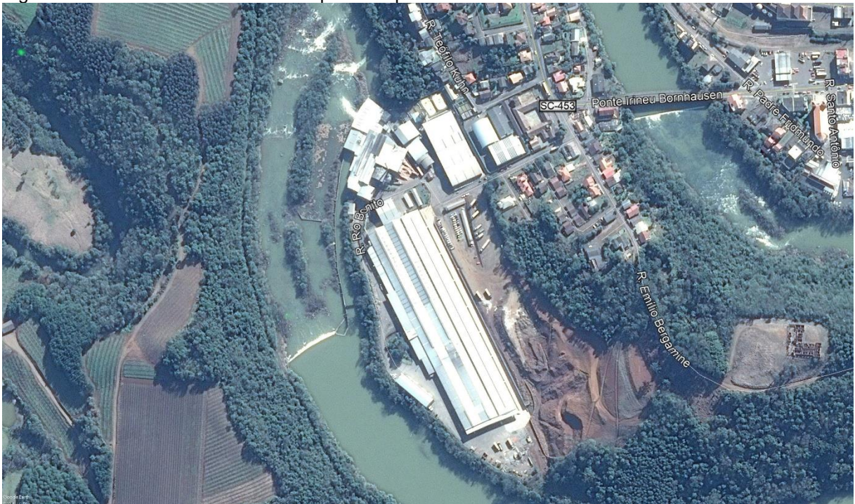
Figura 34 - Barramento ao lado da empresa Sopasta
