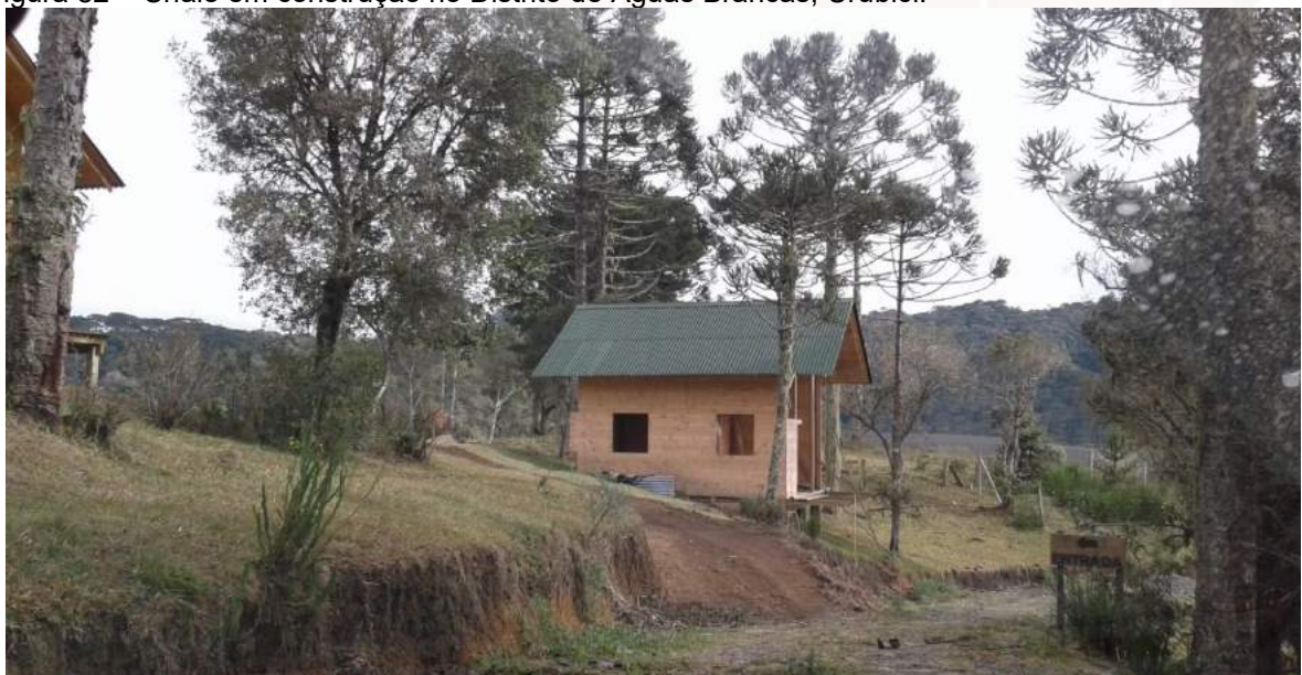
Figura 82 – Chalé em construção no Distrito de Águas Brancas, Urubici.
