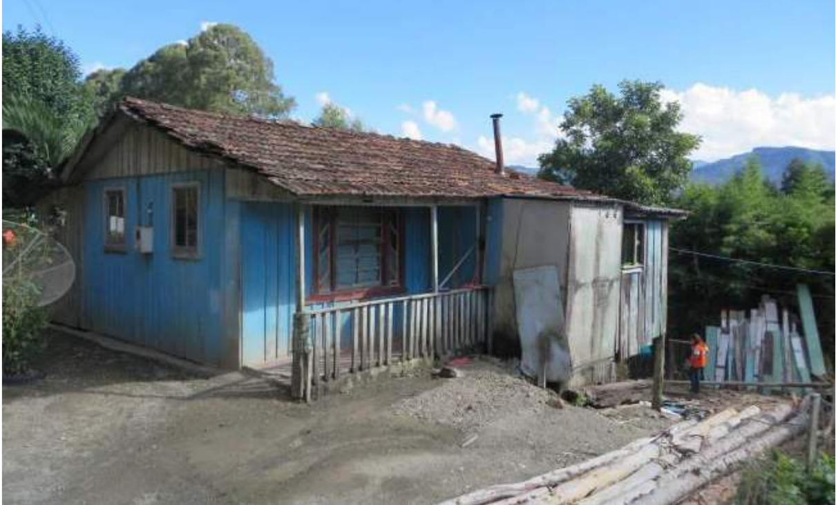
Figura 23 - Tipo de ocupação na margem do Rio Canoas com risco de deslizamento.
