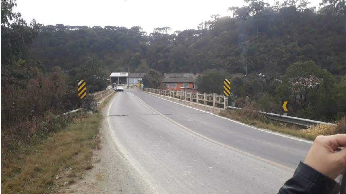
Figura 201 - Levantamento de Navegabilidade - Ponto 01.
