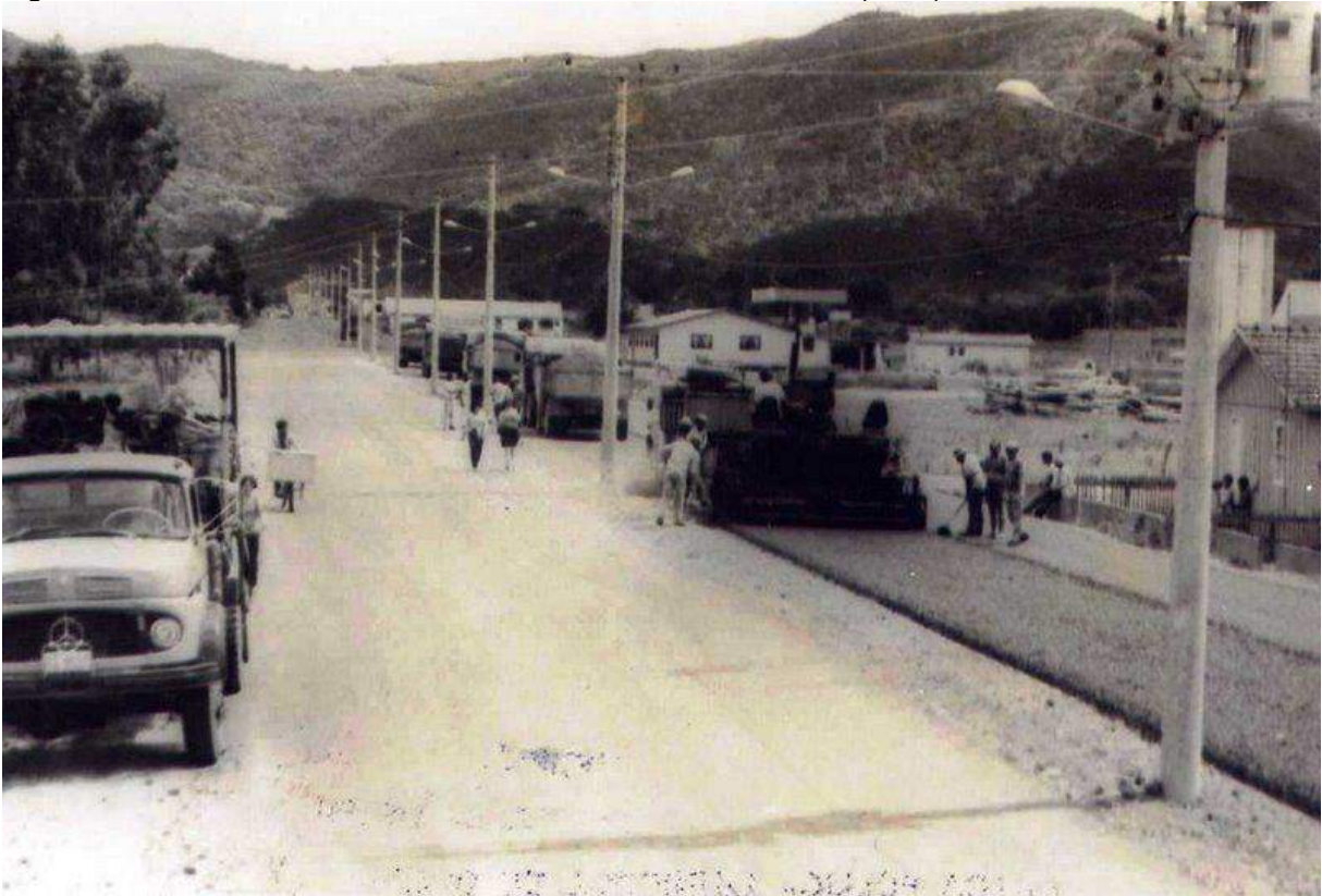
Figura 63 - Primeira camada de asfalto na Avenida Adolfo Konder (1985)
