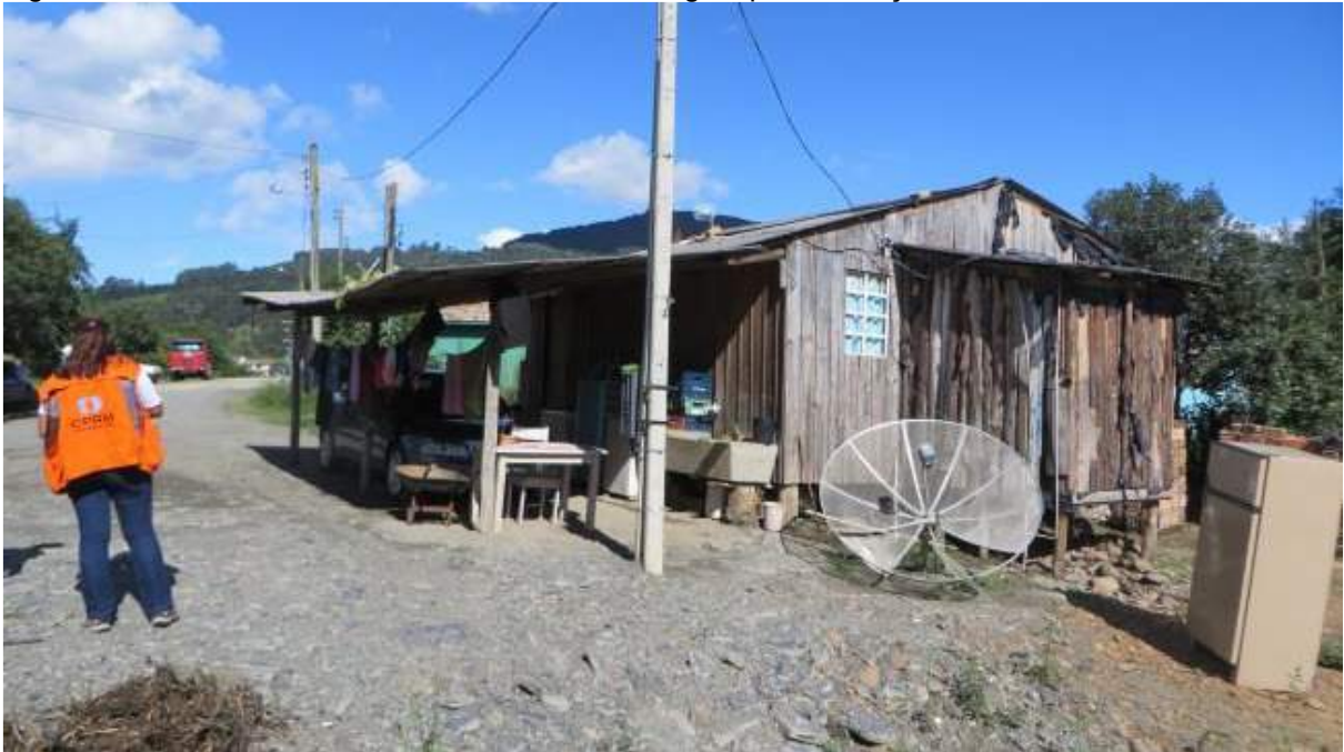
Figura 14 - Residência com alta vulnerabilidade atingida por inundação.
