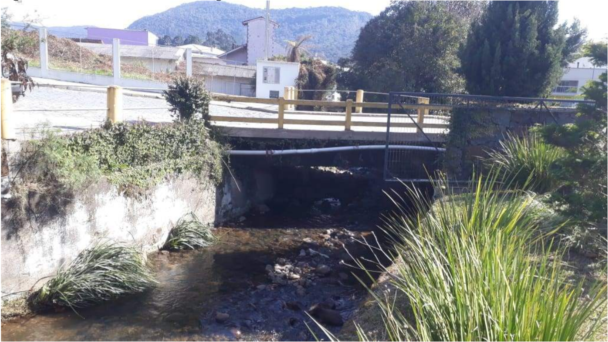
Figura 212 - Levantamento de Navegabilidade - Ponto 06.
