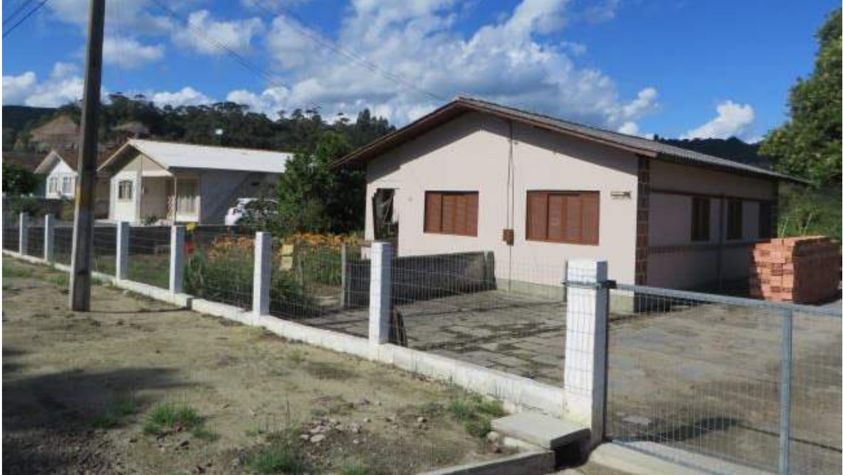
Figura 16 - Ocupação de moderada vulnerabilidade na planície do Rio Canoas, atingida por inundação.
