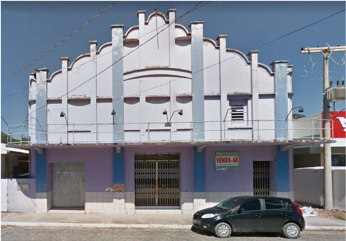
Figura 51 - Fachada do prédio com características Art-Decó, onde funcionava o Cine-Teatro de Urubici localizado no Centro.
