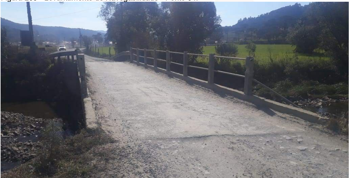
Figura 209 - Levantamento de Navegabilidade - Ponto 04.
