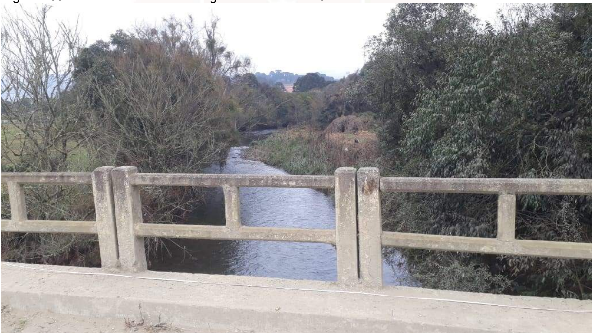
Figura 203 - Levantamento de Navegabilidade - Ponto 02.
