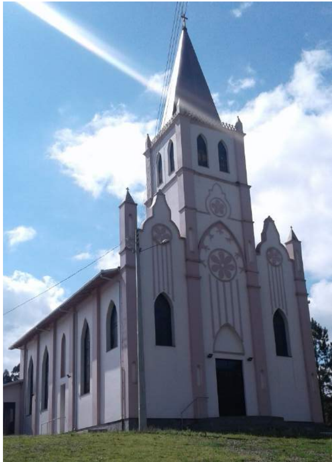
Figura 130 - Igreja na localidade da Consolação na SC-370 (sentido ao município de Rio Rufino), Urubici.
