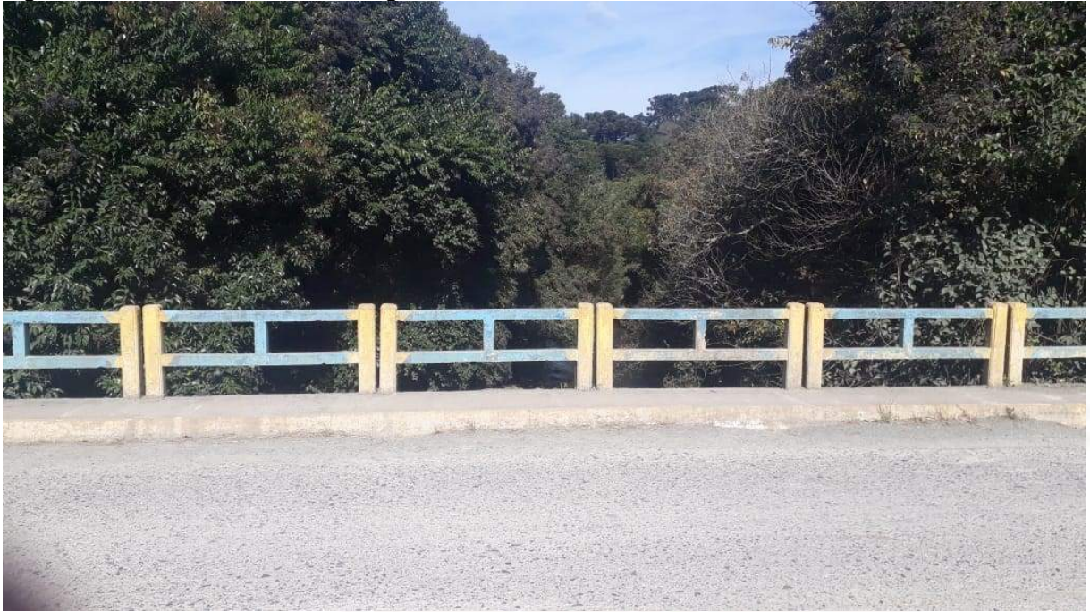
Figura 206 - Levantamento de Navegabilidade - Ponto 03.
