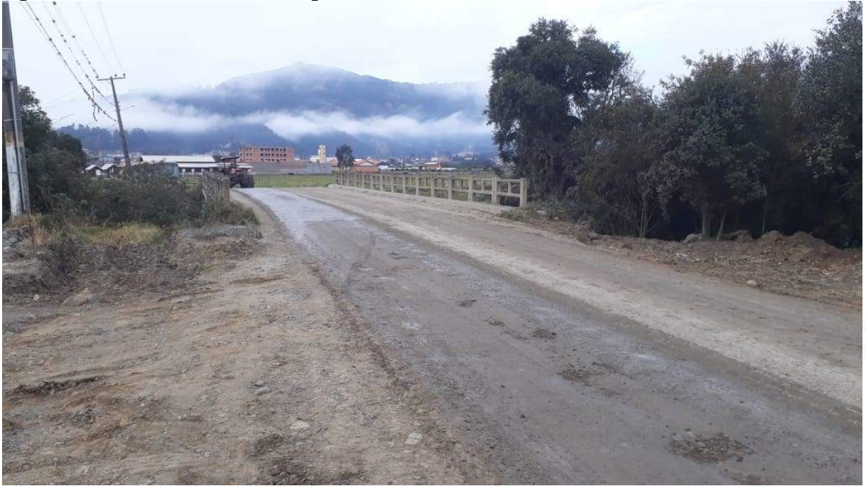
Figura 199 – Levantamento de Navegabilidade - Ponto 01.
