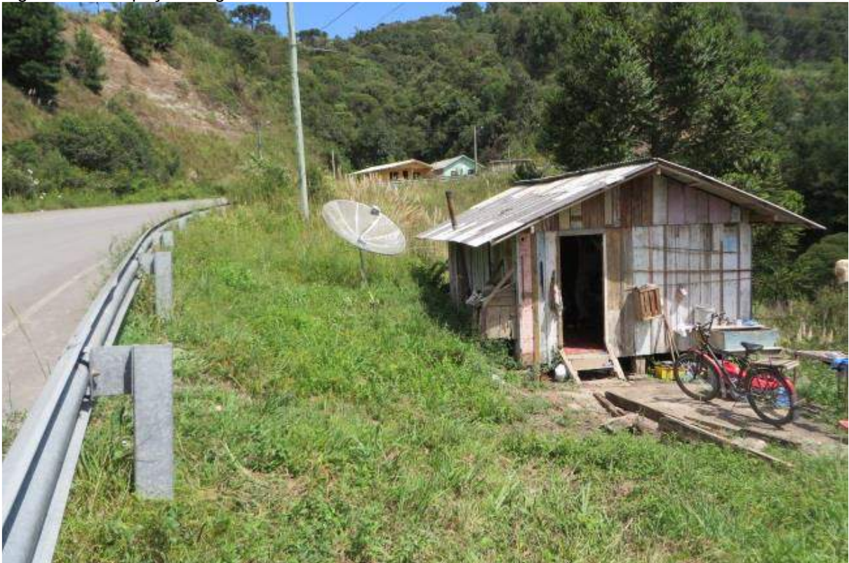
Figura 21 - Ocupação irregular na área de domínio da rodovia com risco de deslizamento.
