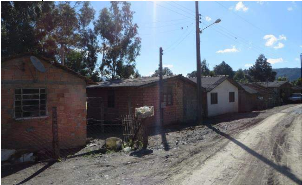
Figura 26 - Tipo de ocupação de alta vulnerabilidade no setor de risco 7 que conta ainda com infraestrutura precária.
