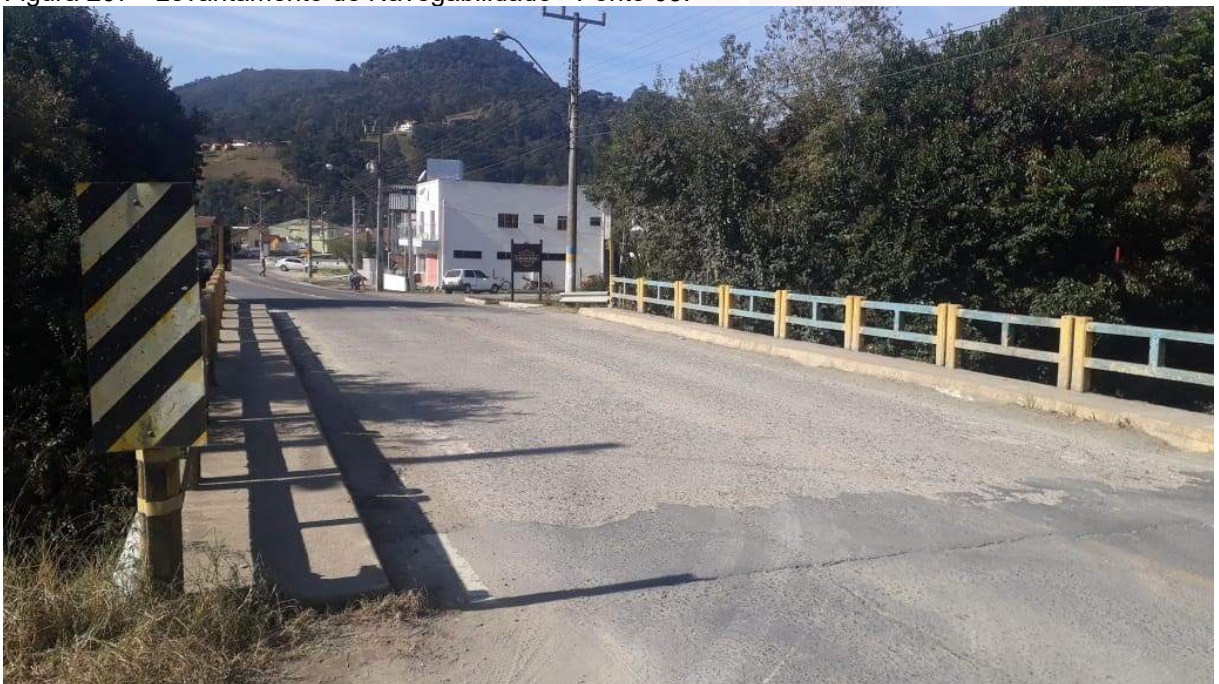
Figura 207 - Levantamento de Navegabilidade - Ponto 03.
