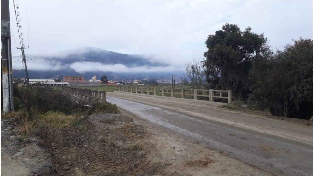
Figura 202 - Levantamento de Navegabilidade - Ponto 02.
