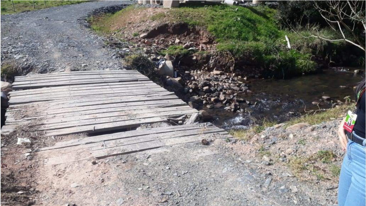
Figura 210 - Levantamento de Navegabilidade - Ponto 05.
